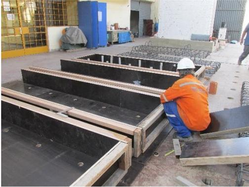
Foto 1. Encofrado y armado de la base de cimentación.
