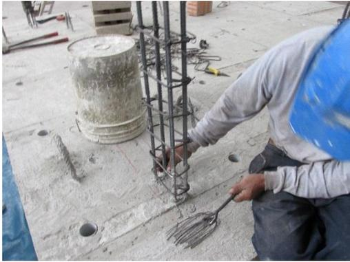
Foto 7. Colocación de los estribos en las columnas.
