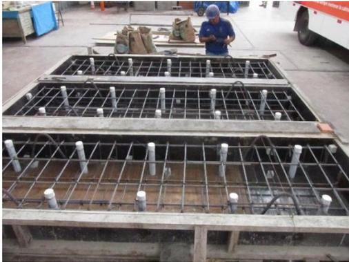
Foto 3. Colocación de los tubos de 2” en las bases de cimentación.
