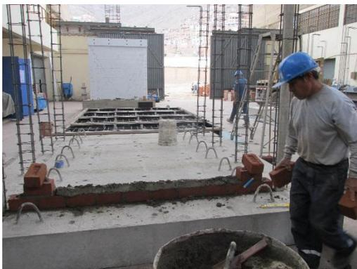
Foto 9. Vista de la primera hilada del muro de ladrillos sólido.
