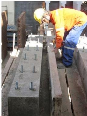
Foto 21. Desencofrado de la viga.
