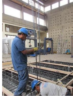
Foto 2. Colocación final de los aceros longitudinales de las columnas en las vigas de base.
