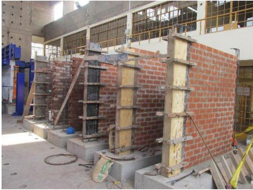
Foto 13. Encofrado de las columnas.
