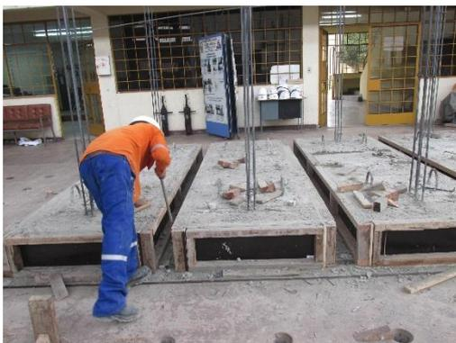
Foto 5. Desencofrado de las bases de cimentación.
