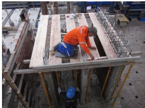
Foto 18. Encofrado de las vigas.
