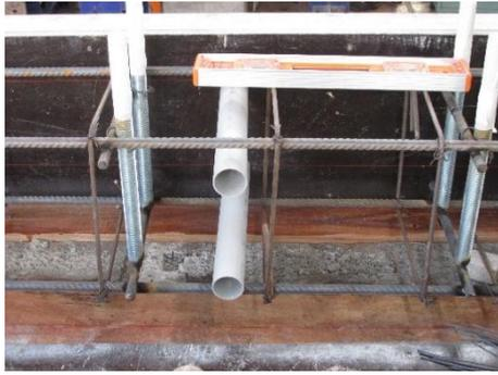
Foto 19. Colocación de tubos en las vigas.
