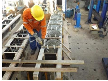
Foto 20. Vaciado y vibrado de las vigas.
