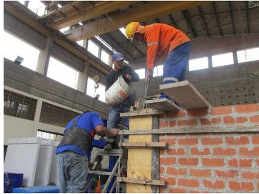
Foto 14. Vaciado de concreto y vibrado de la columna.
