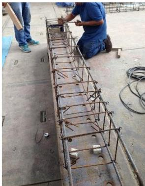
Foto 17. Armado de las vigas.
