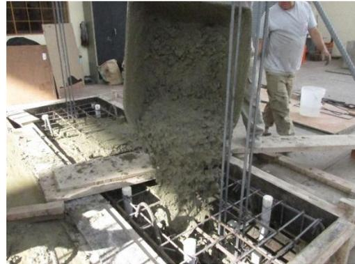
Foto 4. Vaciado y vibrado del concreto en las vigas de base.
