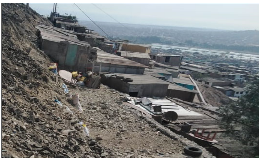
Figura N°45. Cerro pendiente moderada, se observa material disgregado.
