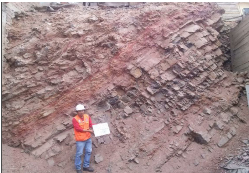
Figura N°49. Vista del Talud T-03. Fuente: CISMID 2015.
