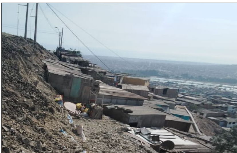
Figura N°43. Corte de ladera para edificación de vivienda precaria.
