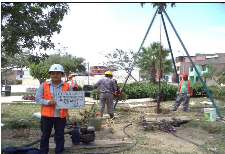
Figura N°48. Vista panorámica del ensayo SPT-01. Fuente: CISMID 2015.
