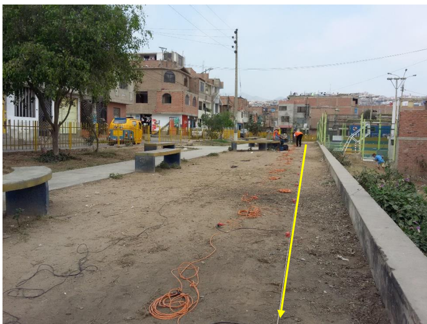
FOTO 10: LS-10, se observa el tendido de cables y su conexión con los geófonos para el ensayo de refracción sísmica. Este ensayo fue realizado al costado del Policlínico Sagrada Familia ubicado en la calle 4.
