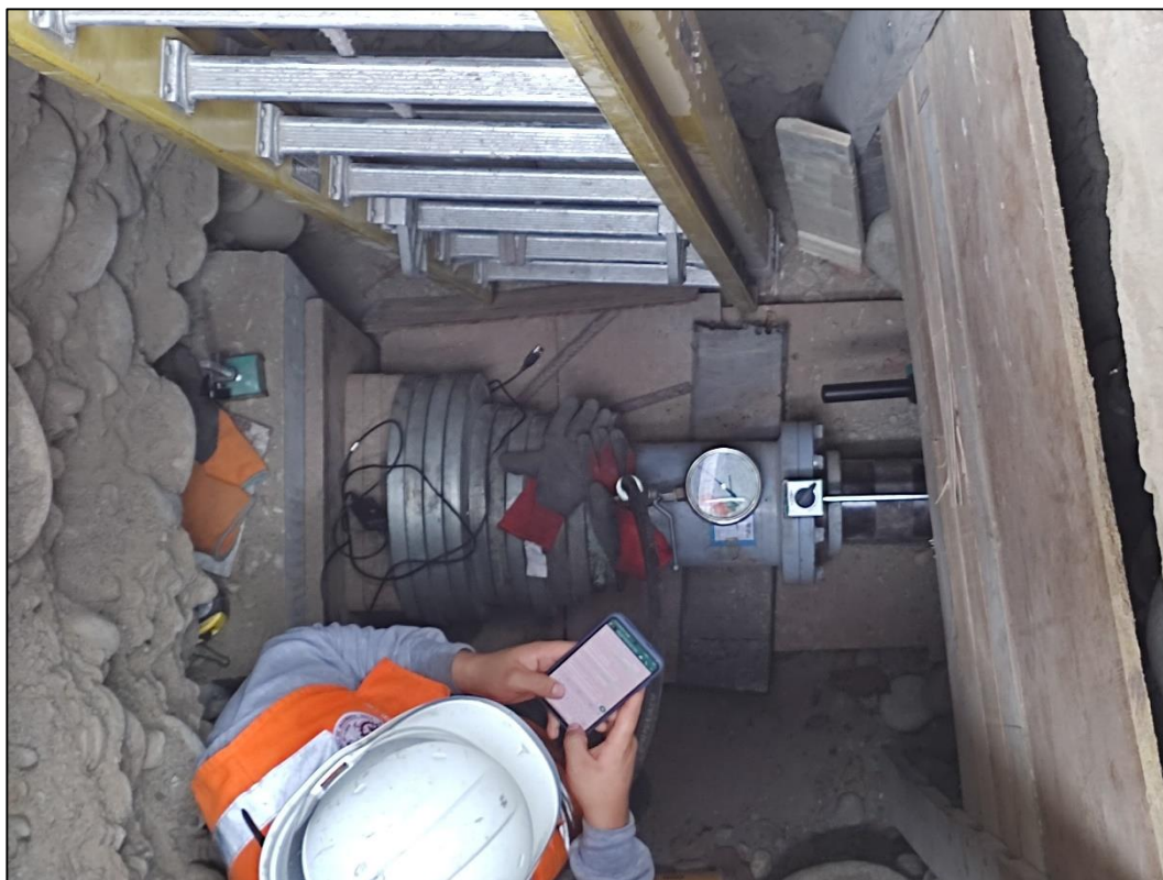
Figura 47. Fotografía del procedimiento de ejecución de la segunda prueba de carga horizontal.
