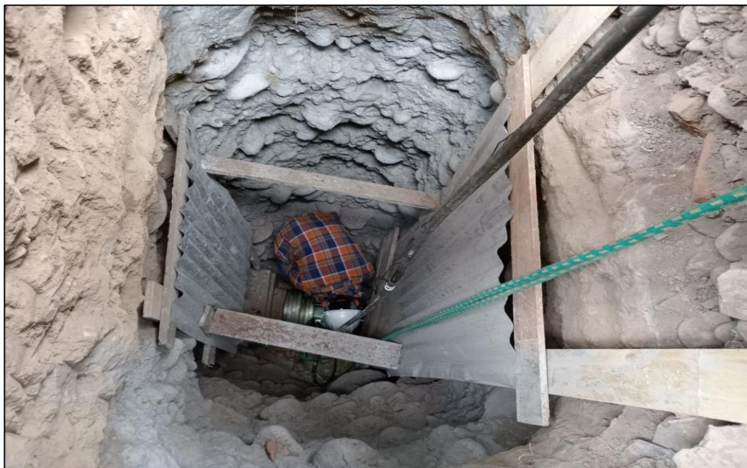
Figura 30. Fotografía de la calicata C-01 de 4.30m de profundidad, donde se empleó un sistema de entibado de madera y una capa ligera de shotcrete
