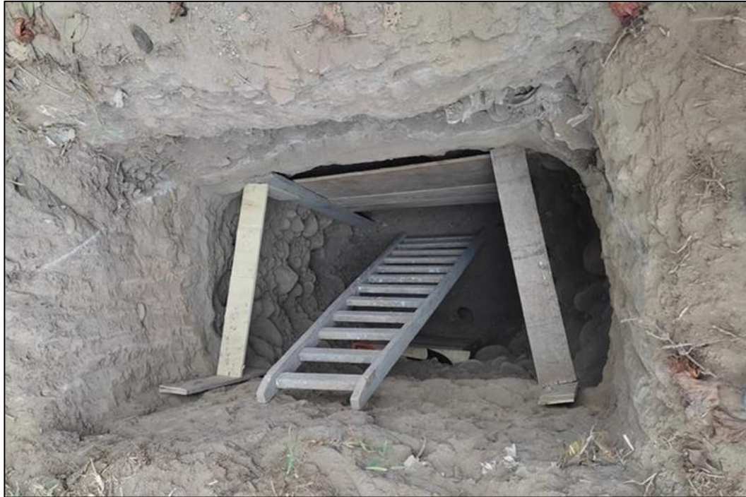
Figura 29. Fotografía de la calicata C-01 de 3.30m de profundidad, donde se empleó un sistema de entibado de madera
