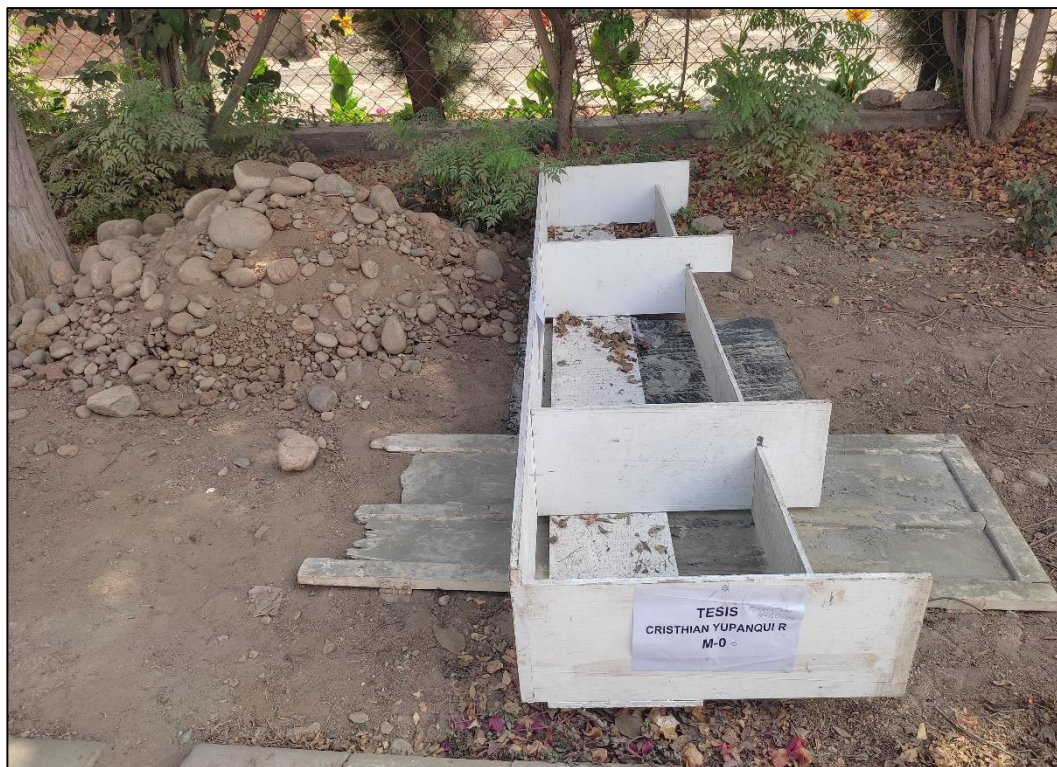
Figura 27. Fotografía de las maderas y tablas para cubrir la calicata superficial C-02
