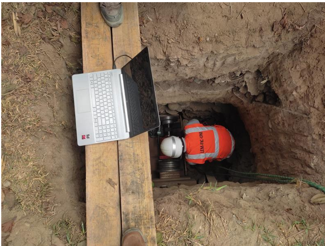
Figura 45. Fotografía del procedimiento de ejecución de la primera prueba de carga horizontal.
