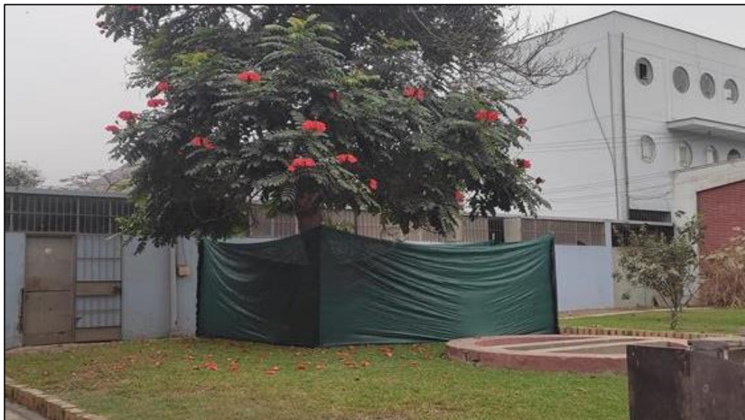
Figura 26. Fotografía de la delimitación para trabajos en la calicata C-01 empleando malla raschel
