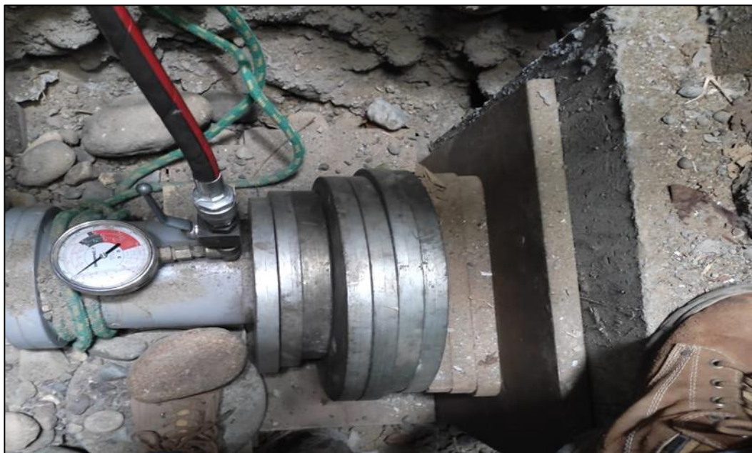
Figura 38. Fotografía de las placas de acero para rellenar los espacios vacíos entre el dado de concreto y la pared vertical de grava.
