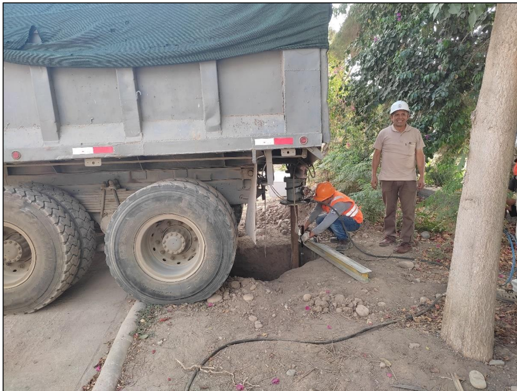
Figura 52. Fotografía del procedimiento de ejecución del segundo intento de la prueba de carga vertical.
