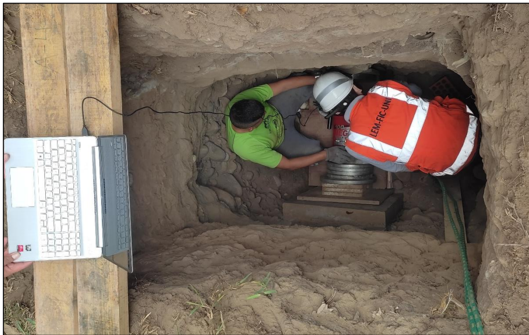
Figura 43. Fotografía del procedimiento de la colocación de la gata hidráulica y las placas de acero para rellenar los espacios vacíos entre el dado de concreto y la gata hidráulica.
