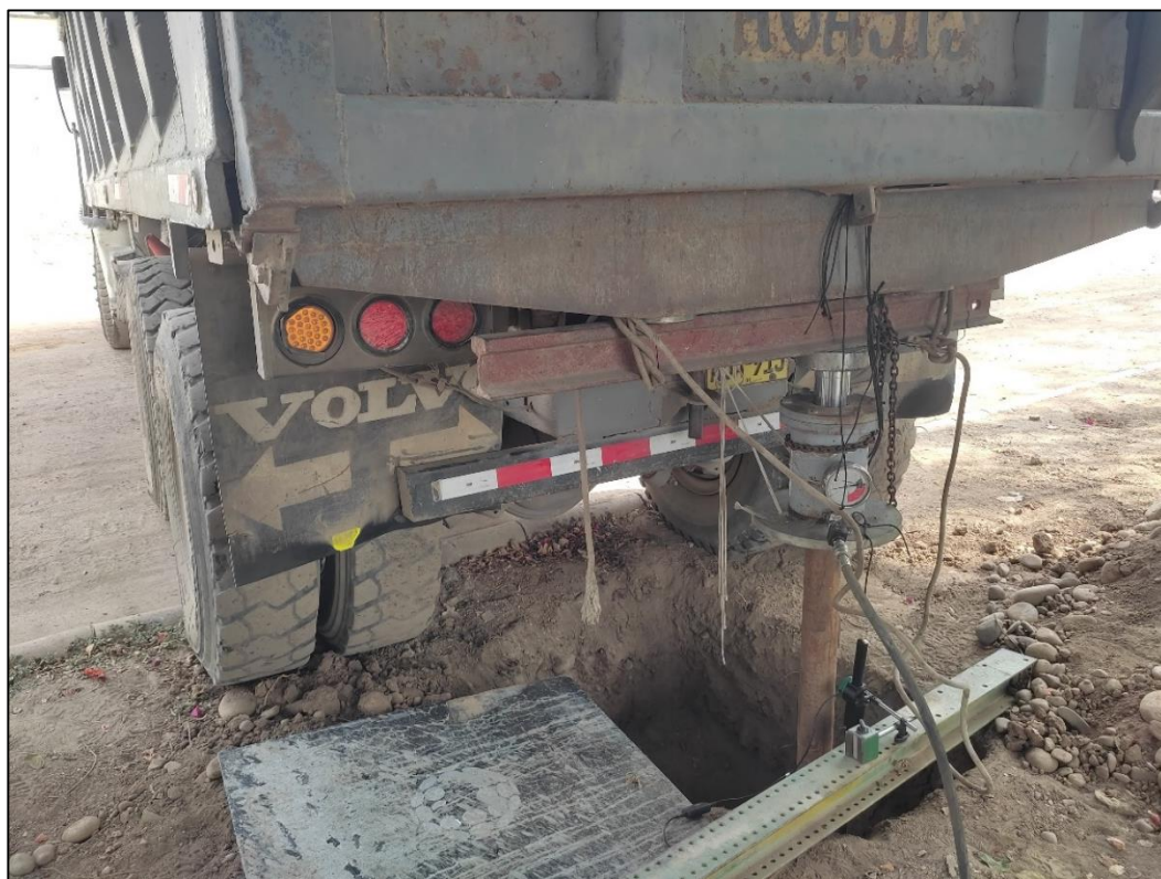
Figura 51. Fotografía del procedimiento de ejecución del primer intento de la prueba de carga vertical.
