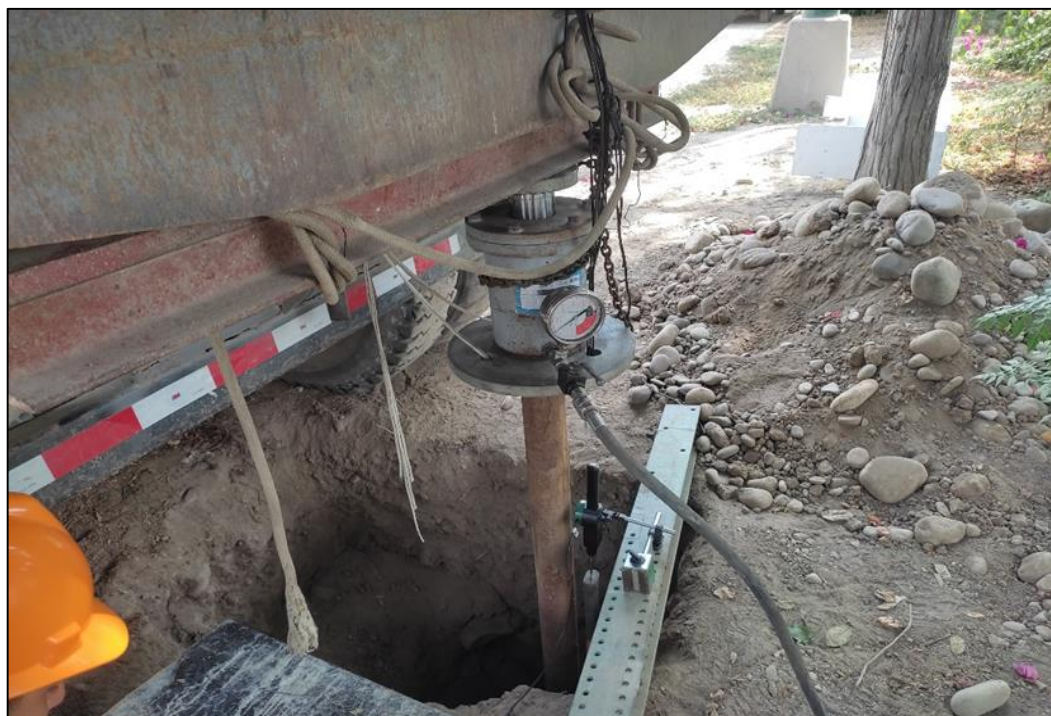
Figura 44. Fotografía de la instalación de los elementos y dispositivos para la realización del ensayo de carga vertical.
