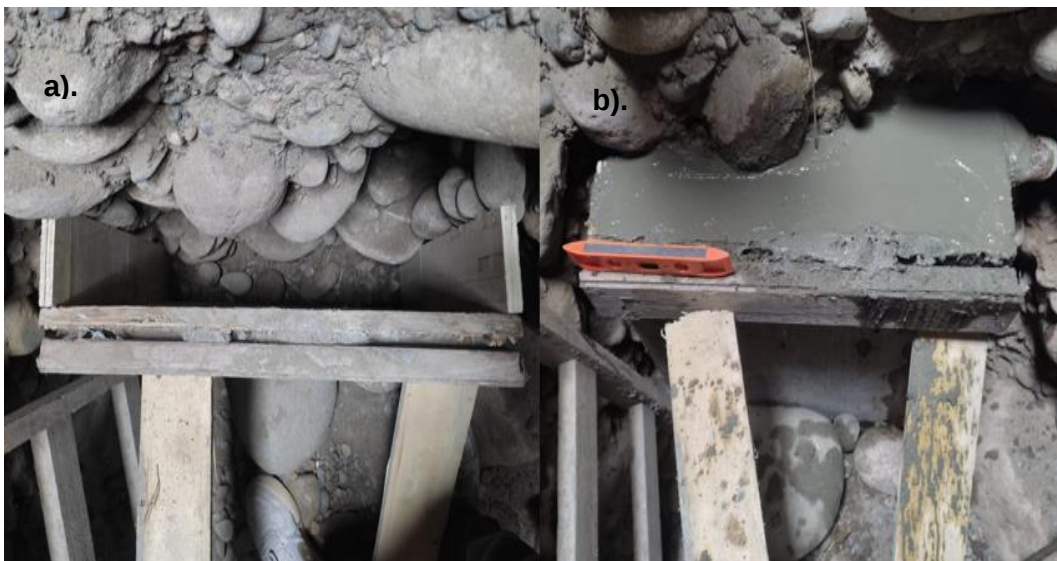
Figura 35. (a) Encofrado del dado de concreto, (b) Vaciado del dado de concreto
