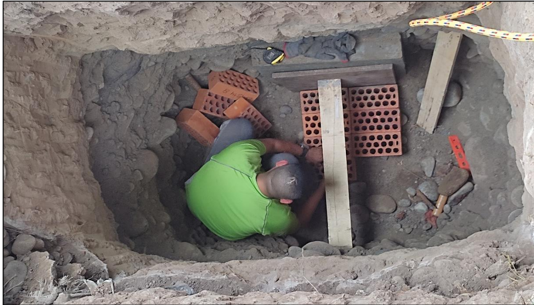
Figura 42. Fotografía del procedimiento de nivelación como base apoyo de los dispositivos
