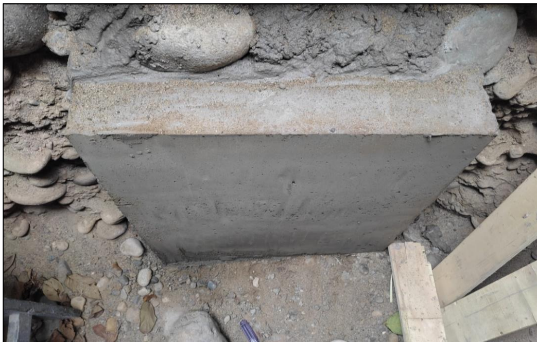
Figura 36. Fotografía del dado de concreto de 0.60mx0.60mx0.15m terminado
