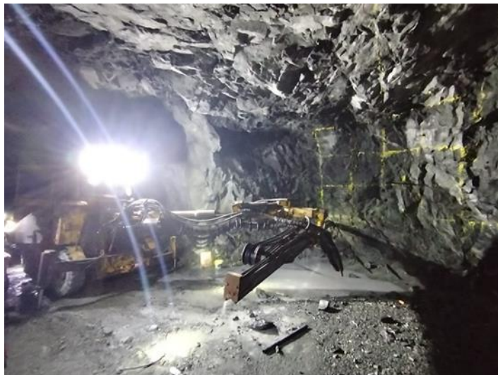
Perforación de jumbo en L
