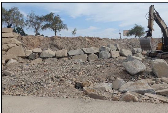
Nota5: Enrocado en la defensa ribereña.
