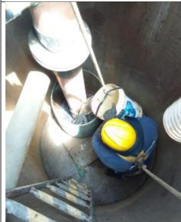
Fig. 03. Suministro de agua de mar
