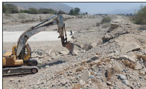
Nota4: Excavación para el enrocado para la defensa ribereña.
