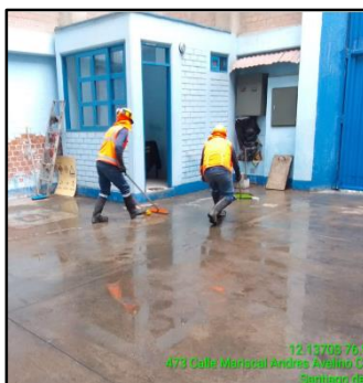
Nota2: Limpieza y Baldeo
