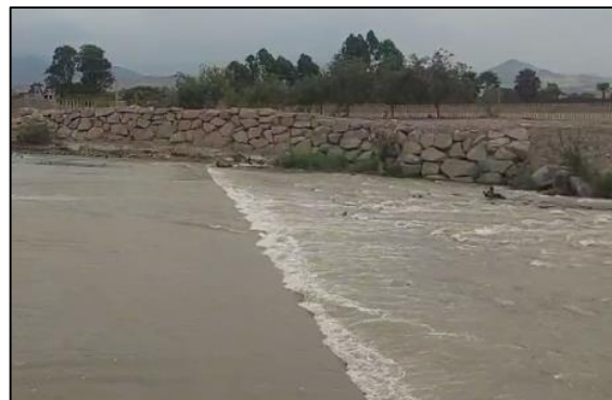
Nota6: Trabajo terminado y vista del cruce en época de avenida.
