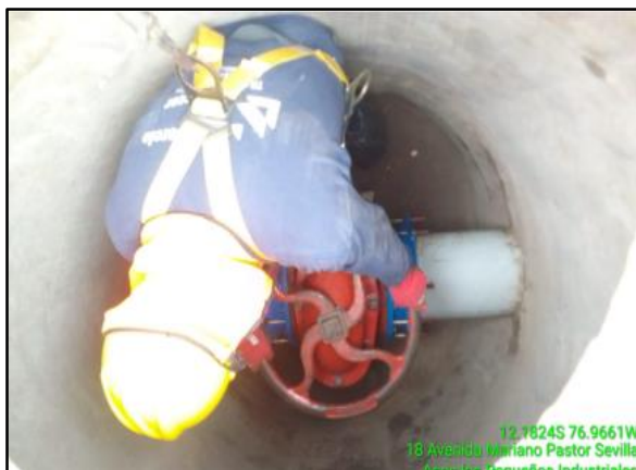
Nota3: Apertura de la compuerta para el purgado
