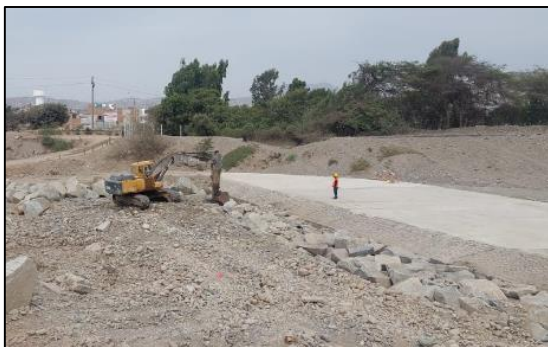
Nota3: Colocación de rocas en paralelo al costado del Rip-Rap aguas abajo, para amortiguar la caída del agua en avenidas.
