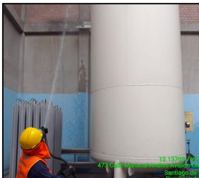
Nota1: Lavado de tanque
