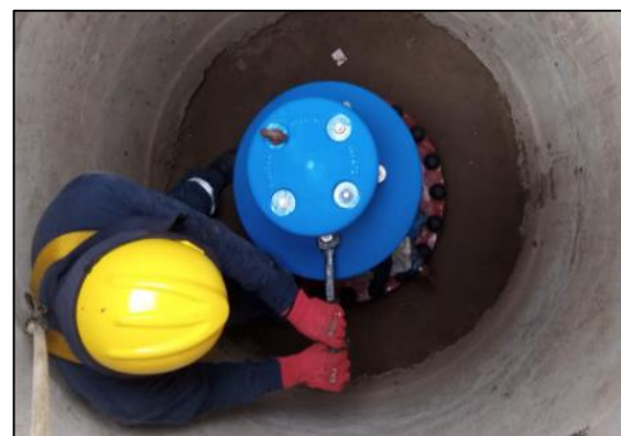
Nota4: Colocación e instalación de la válvula
