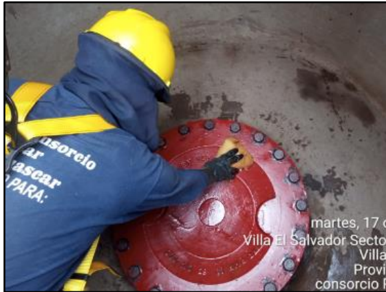
Nota1: Limpieza y Lavado de la Brida Ciega
