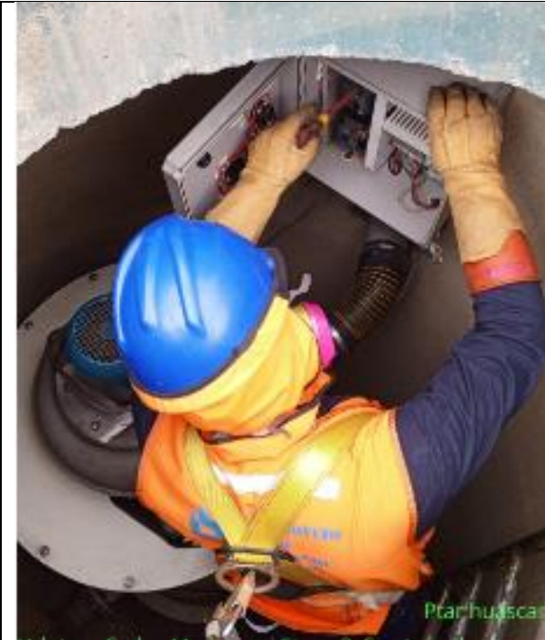
Fig. 01. Mantenimiento preventivo de tablero de mando y corte de flujo eléctrico.
