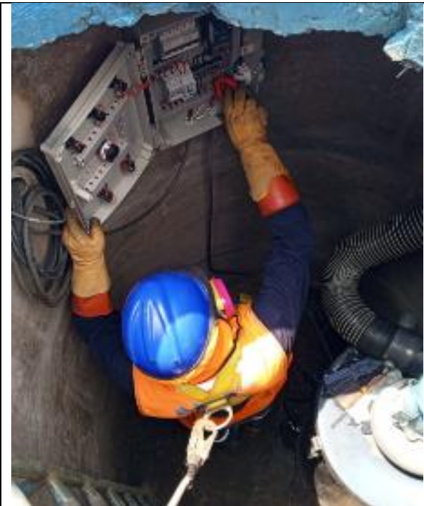
Fig. 01. Mantenimiento preventivo de tablero de mando y corte de flujo eléctrico.
