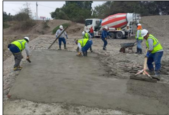
Nota2: Vaciado del concreto pre-mezclado para protección del Rip-Rap.
