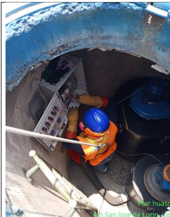
Fig. 01. Mantenimiento preventivo de tablero de mando y corte de flujo eléctrico.
