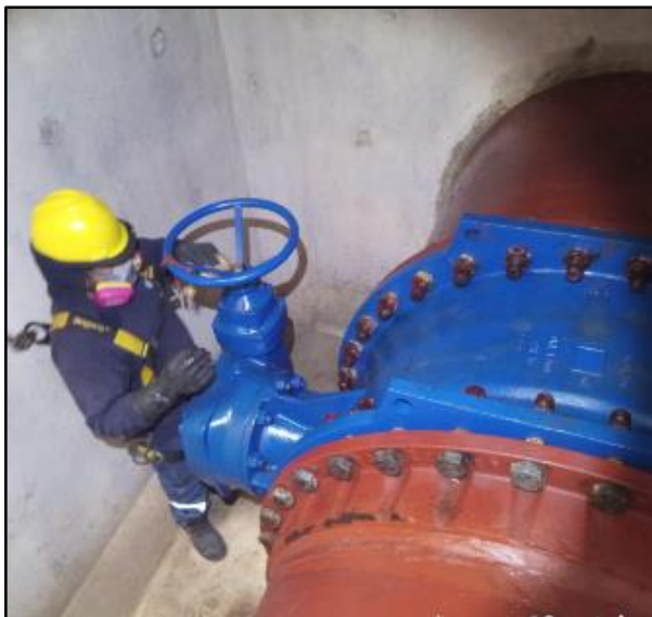
Nota1: Limpieza y Lavado de la válvula
