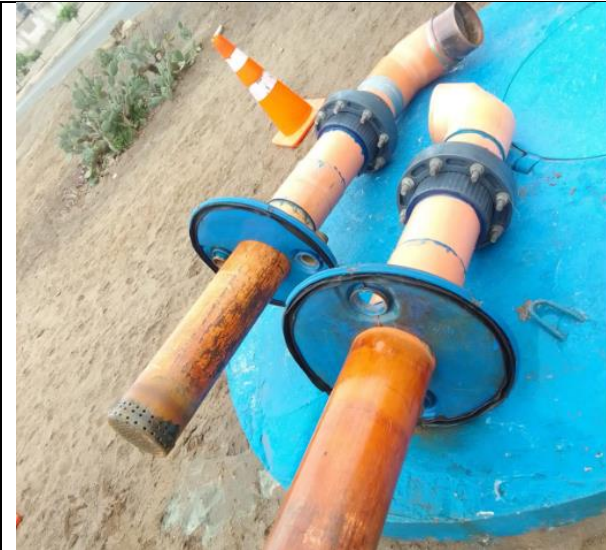
Fig. 01. Sistema artesanal control de olores
