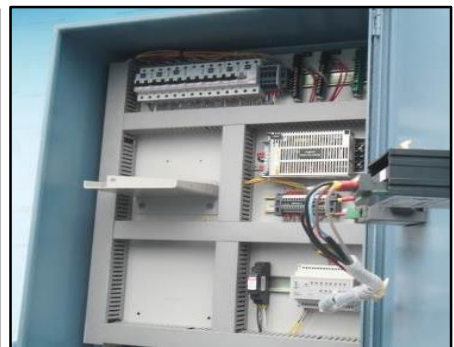
Nota3: Mantenimiento Tablero eléctrico
