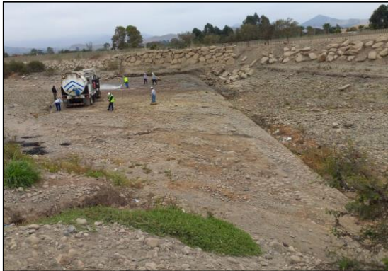
Nota1: Limpieza y Lavado de la protección Rip-Rap en época de sequía.
