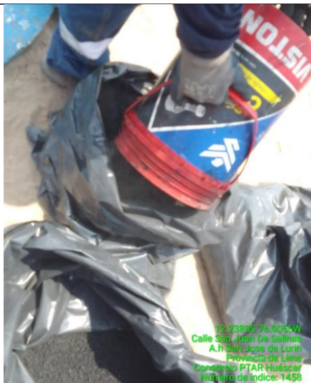
Fig. 02. Eliminación de Carbón activado.
