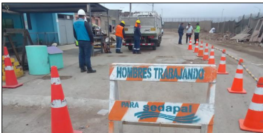
Señalización del área de trabajo
