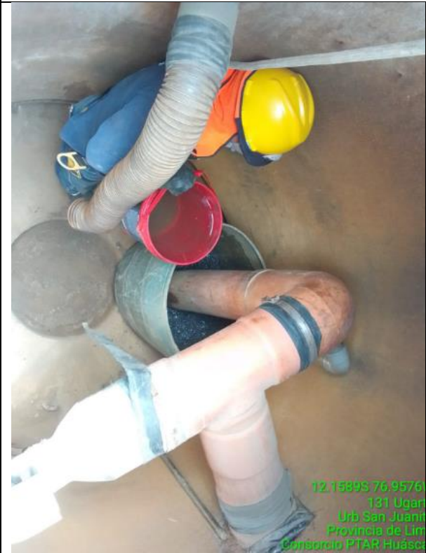
Fig. 03. Suministro de agua de mar
