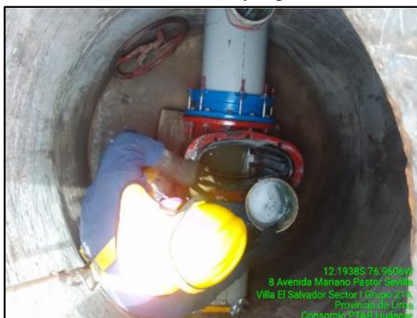
Nota1: Limpieza y Lavado de la válvula
