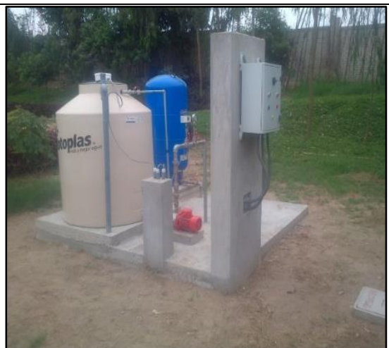
Fig.02: Sistema Hidroneumático
