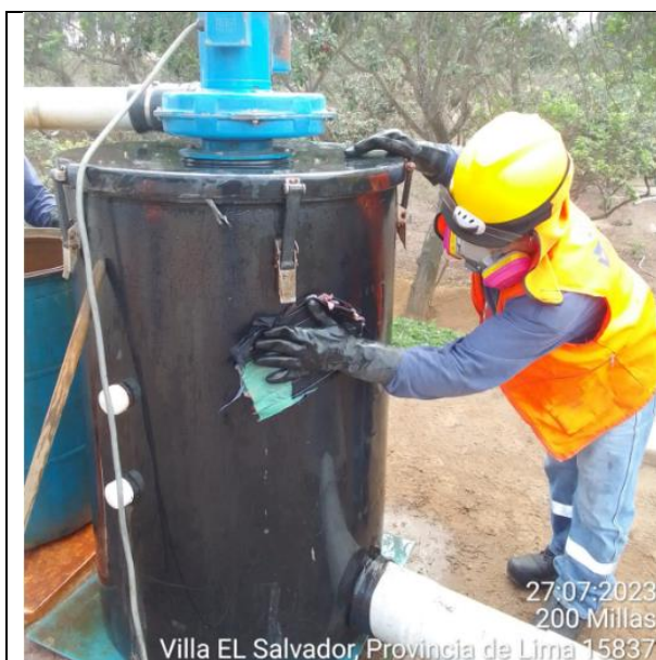
Fig. 01. Sistema artesanal control de olores
