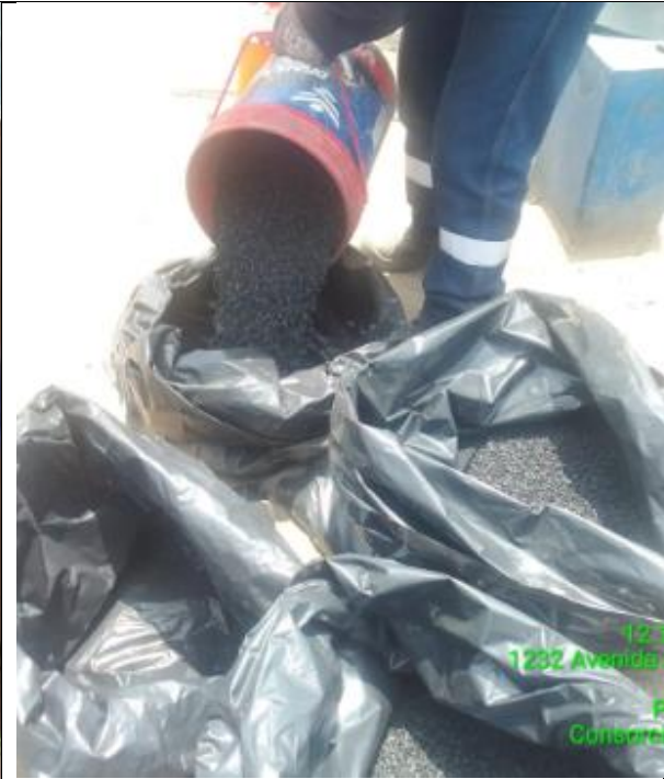
Fig. 02. Eliminación de Carbón activado.
