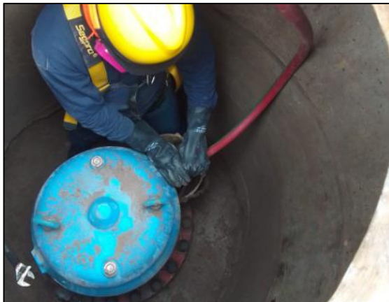
Nota1: Purgado de gases y agua residual
