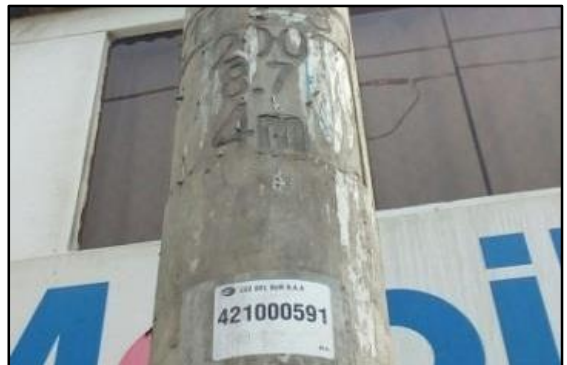
Foto 04: Numero de poste referencia para instalación del suministro
