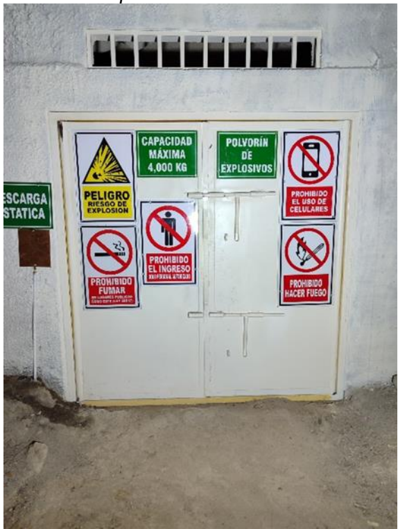
Vista de la puerta del polvorín de explosivos
