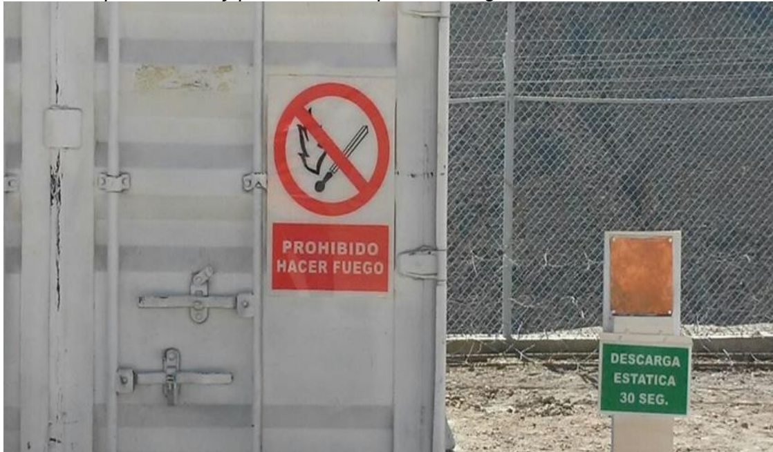
Figura 12 Evidencia de pozo a tierra y placa de cobre para descarga estática
