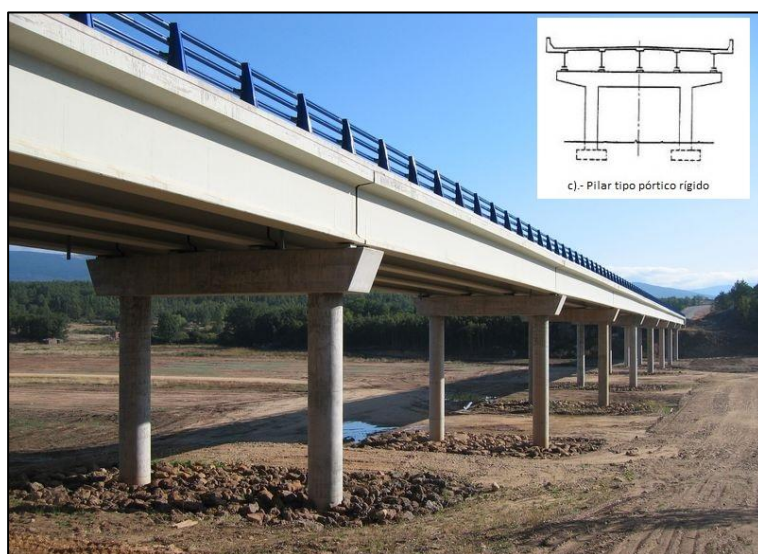
Figura 1.5 Pilares tipo pórtico (dos o más columnas)
