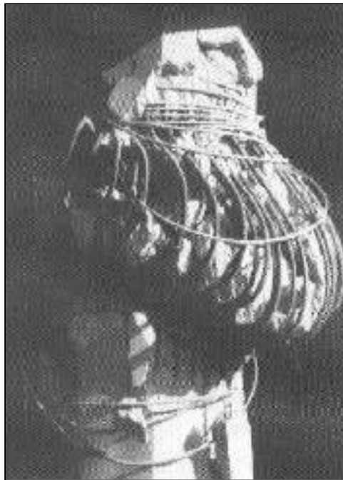
Figura 1.8 Pilar del puente Bull Creek Canyon (Priestley et al. 1994).
