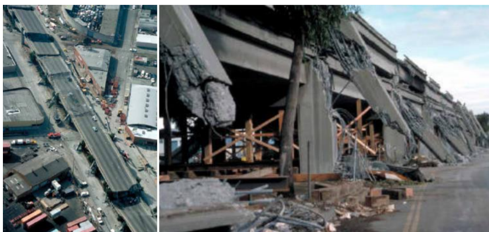
Figura 1.6 Colapso del Viaducto de la calle Cypress (EQE International 1979) (8)
