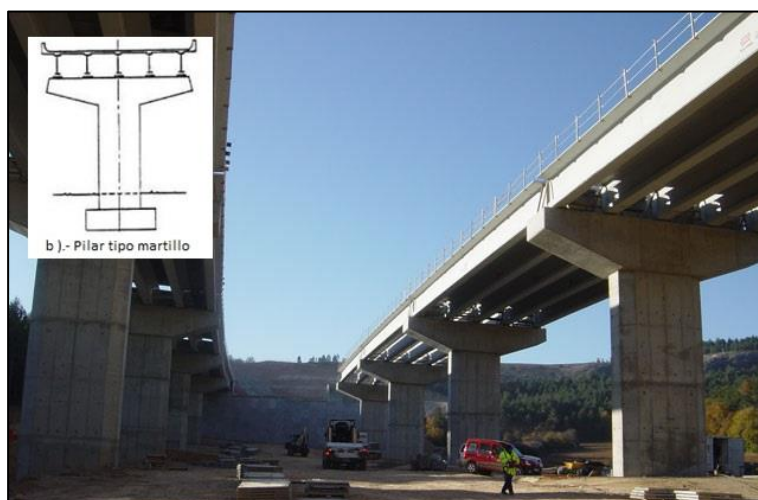
Figura 1.4 Pilares tipo martillo (una sola columna)
