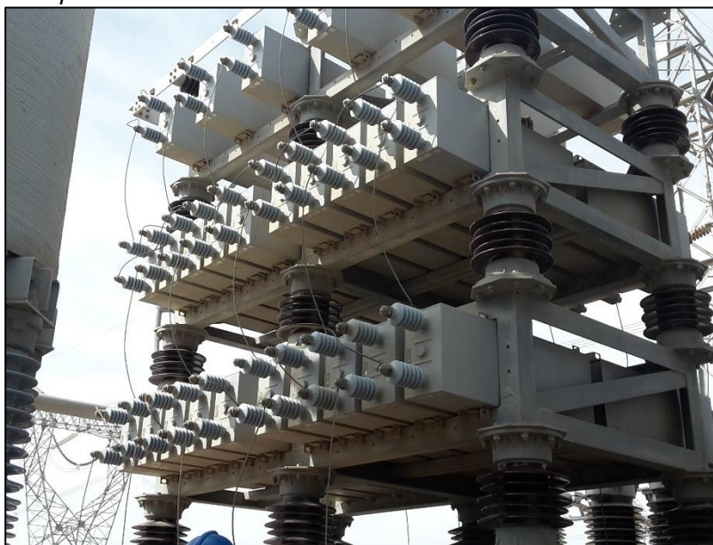
Figura 2.14. Banco de compensación en serie
