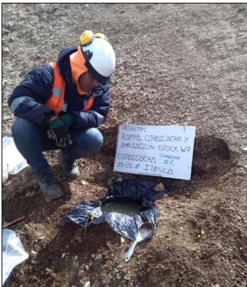
Foto N°08: Vista de ensayo de densidad D-2 Desmonte 3
