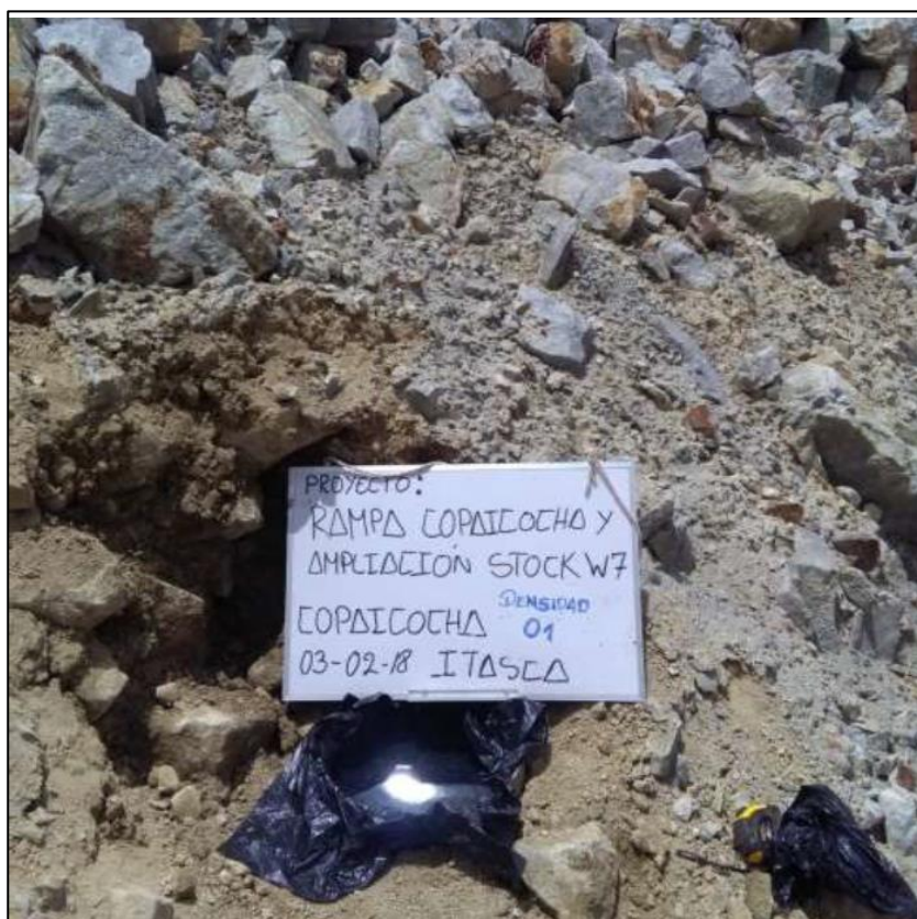
Foto N°07: Vista de ensayo de densidad D-1 Desmonte 1
