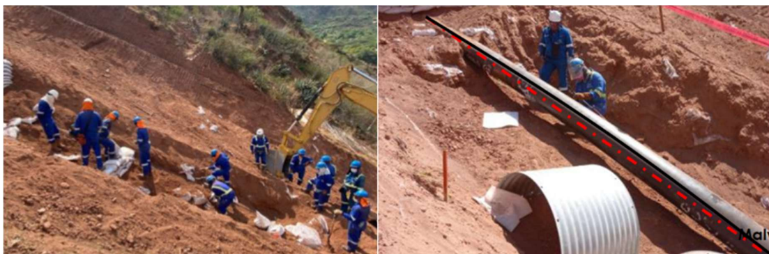
Proceso de liberación de tensiones progresiva KP243+500
