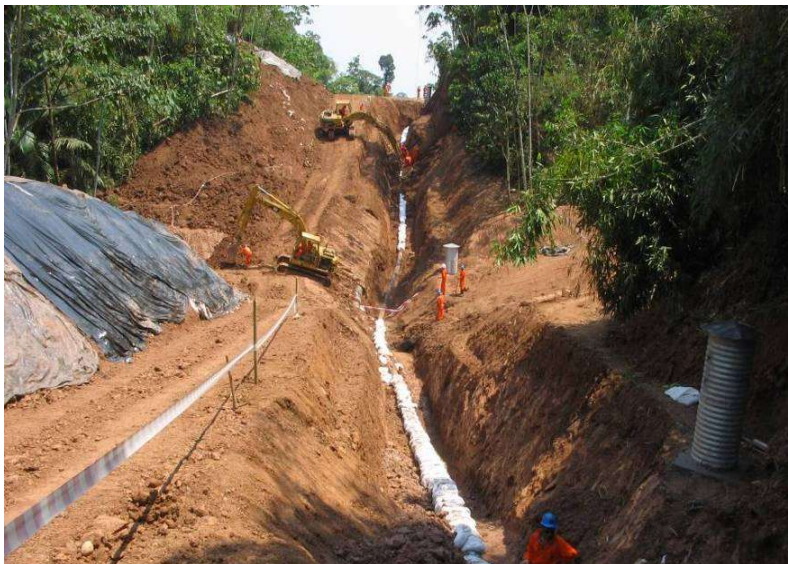
Proceso de liberación de tensiones progresiva KP9+470.
