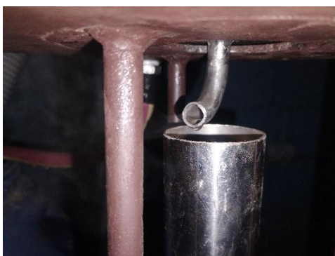
Figura 54: Comienzo del goteo de condensado, recuperado en el vaso Florentino.
