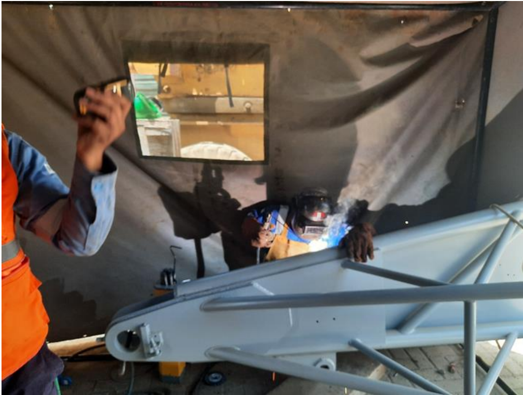
Proceso de soldadura: Seguimiento y control en el proceso de soldadura de base de la pluma
