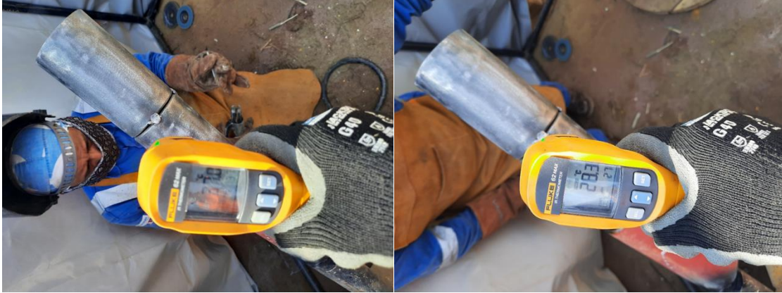
Control de parámetros de soldadura
