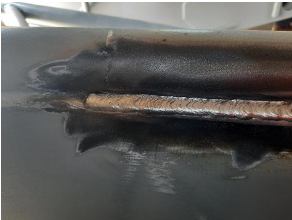
Cordón uniforme sin presencia de socavaciones del punto B
