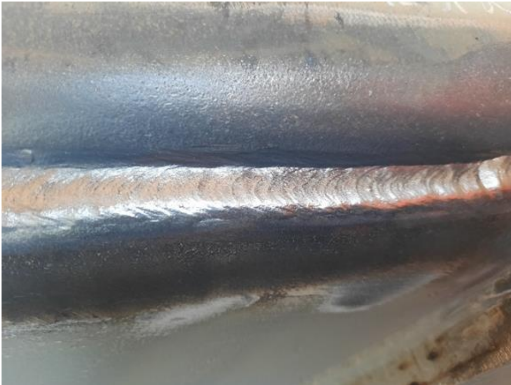
Cordón uniforme sin presencia de socavaciones del punto A
