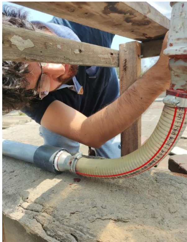
Instalación de recipiente con tubería horizontal
