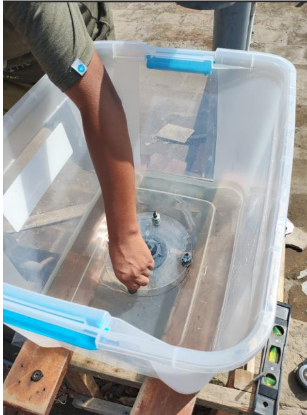
Instalación de pernos para baffle
