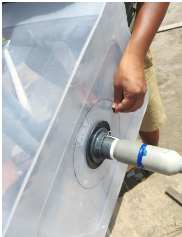
Instalación de empaquetaduras
