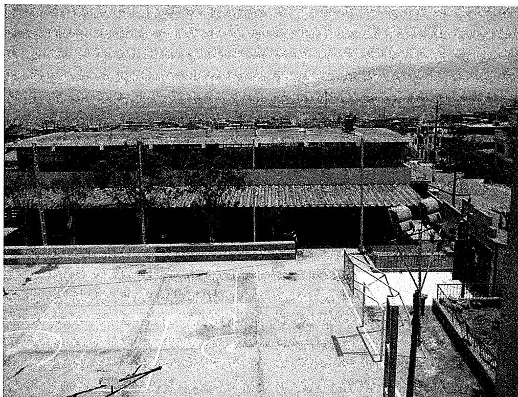
FOTO N° 37. Vista del sentido longitudinal del bloque D – Vista 1.
