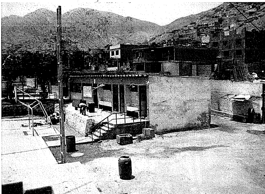
FOTO N° 22. Vista del sentido transversal del bloque C – Vista 2.
