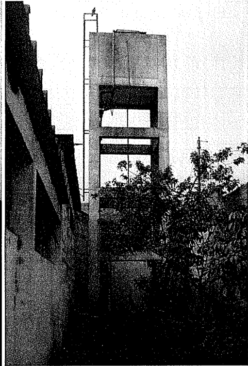
Foto N° 53: Vista del tanque elevado construido por INFES
