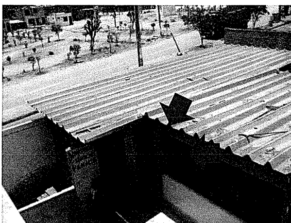
Foto N° 18. Presencia de columnas cortas, por falta de juntas sísmicas entre elementos de rigidez diferente.
