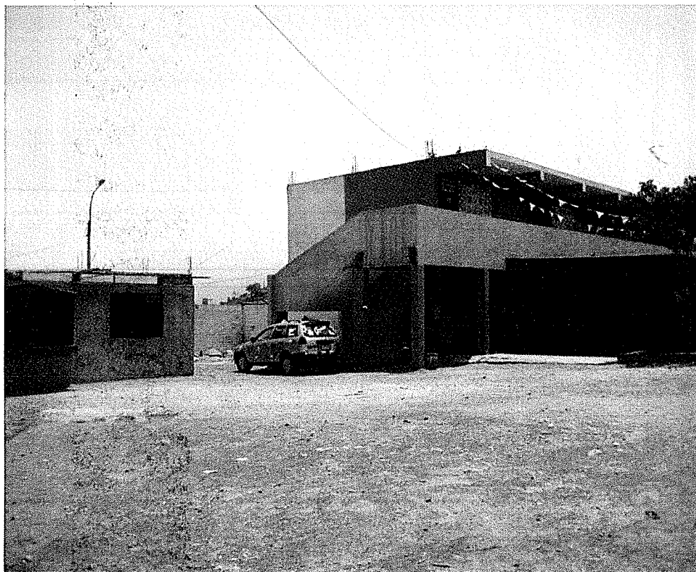
FOTO N° 38. Vista del sentido transversal del bloque D – Vista 2.
