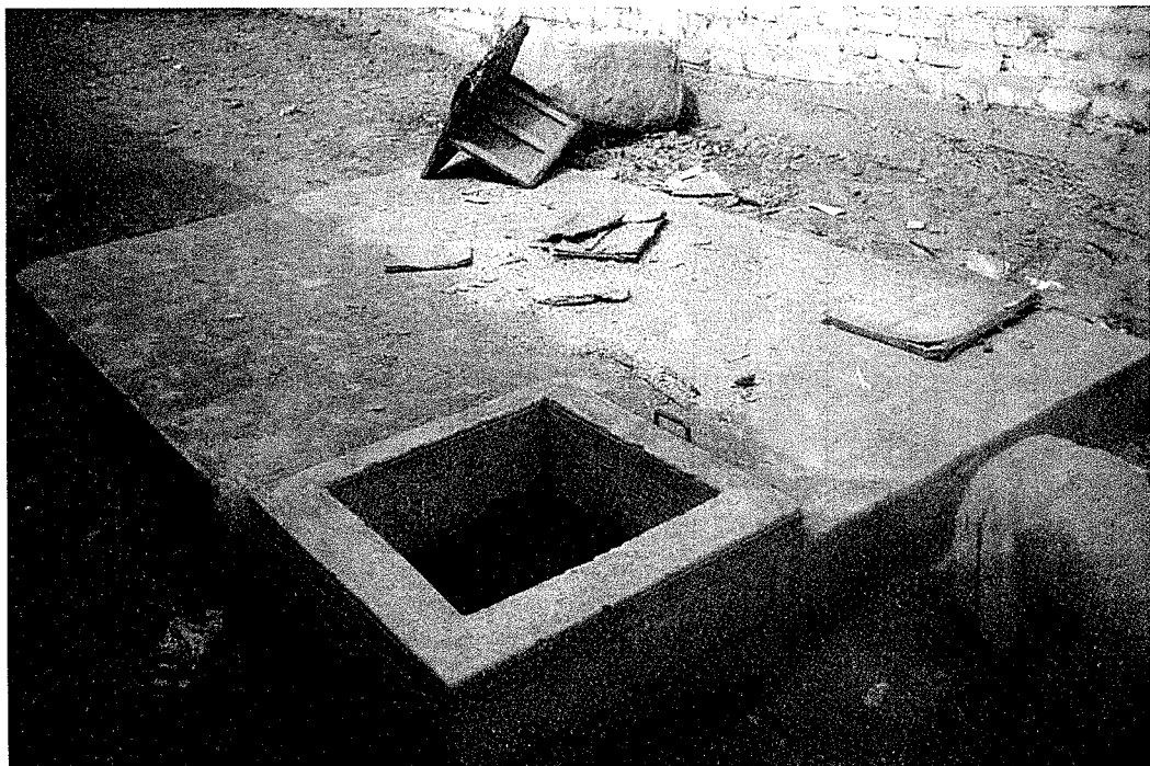
Foto N° 54: Vista de la cisterna construida por INFES
