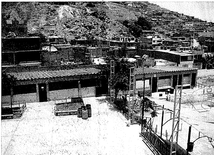
FOTO N° 21. Vista del sentido longitudinal del bloque C – Vista 1.
