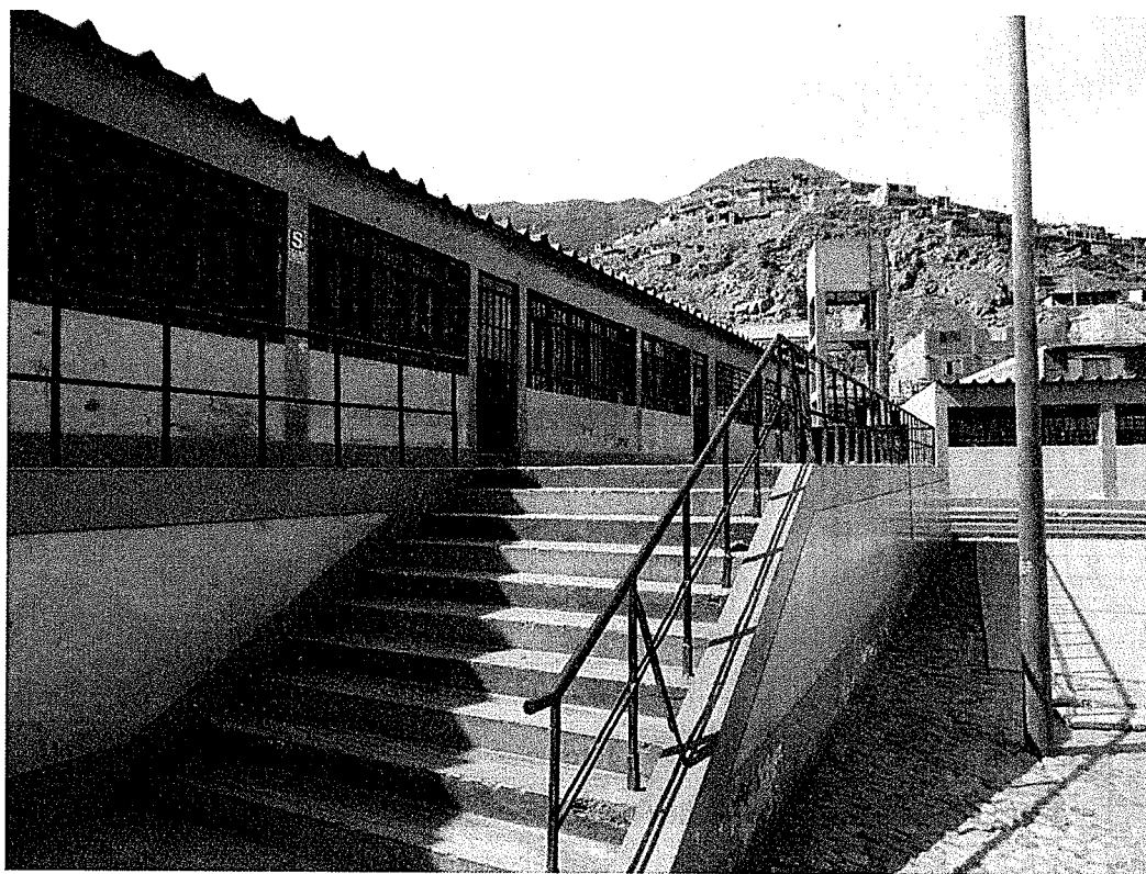
FOTO N° 10. Vista del sentido longitudinal del bloque 02 – Vista 1
