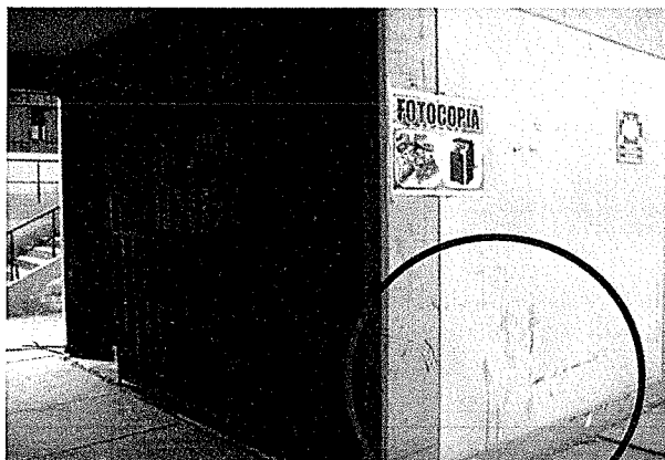
Foto N° 3. Presencia de humedad en los muros
