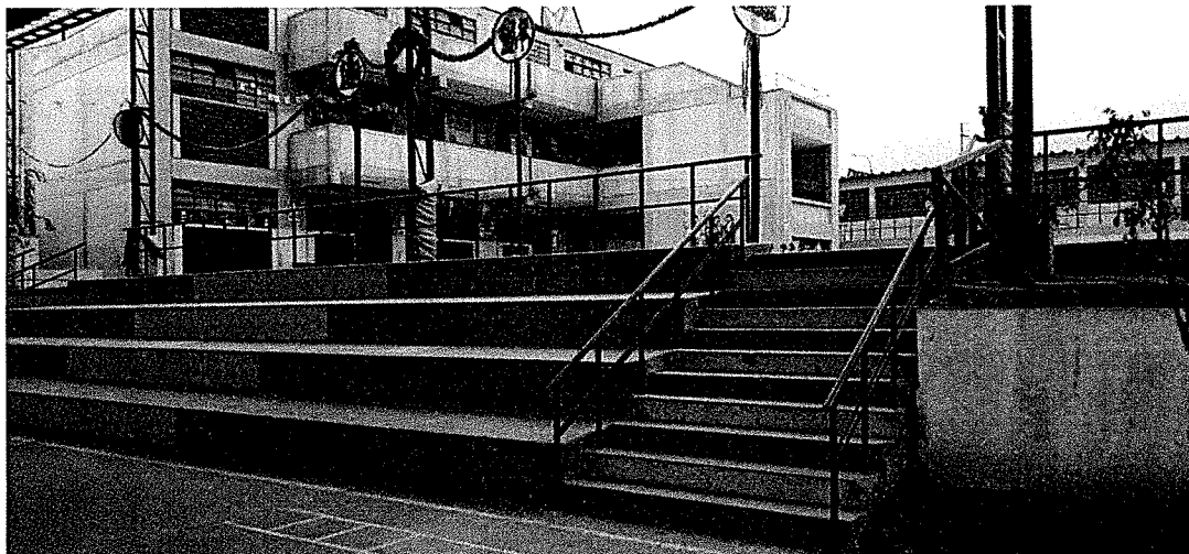
FOTO N° 74. Vista de las escaleras y graderías que separan las plataformas de diferentes niveles dentro de la IE.
