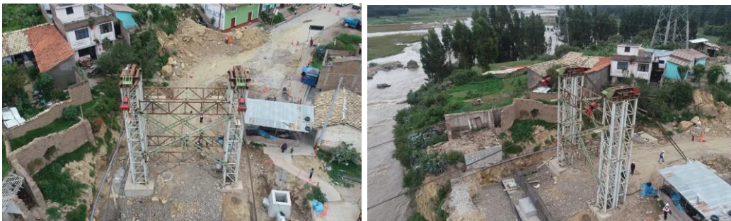
Figura N° 87 Montaje de torre pescante y cables de retenida
