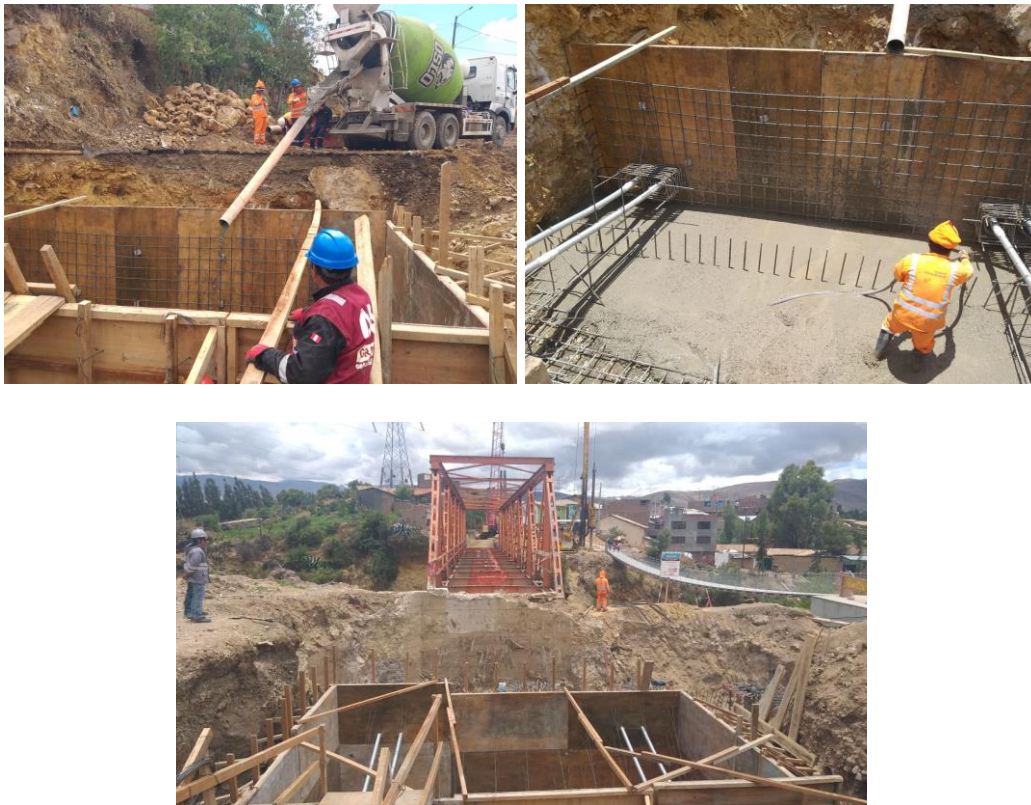
Figura N° 82 Vaciado de cámaras de anclaje de cables
