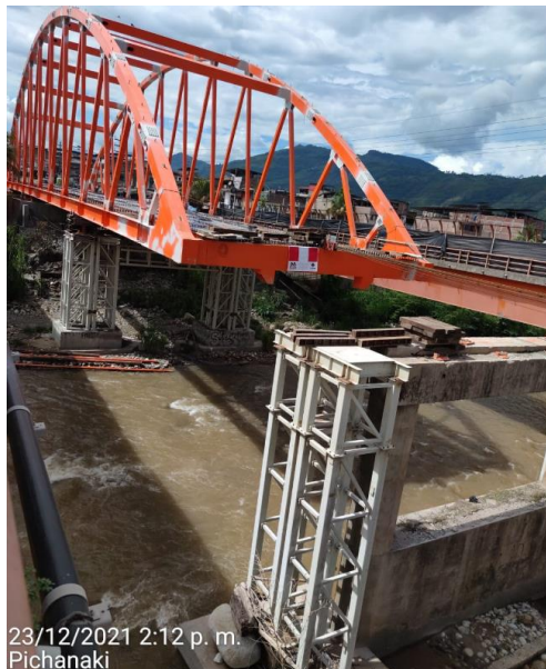
Figura N° 1 Lanzamiento del Puente Pichanaki – Región Junín
