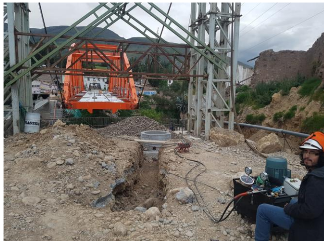
Figura N° 93 Operación del cable de tiro mediante bombas hidráulicas
