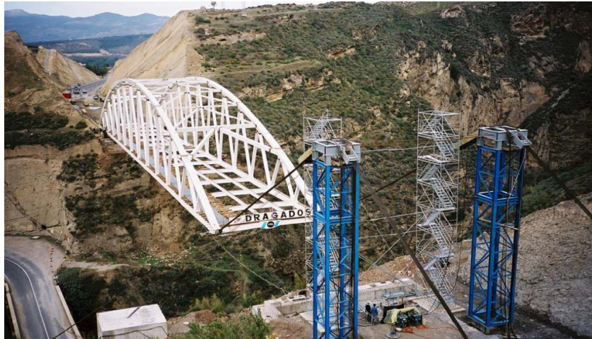
Figura N° 21 Lanzamiento del Viaducto Lanjarón con torre pescante
