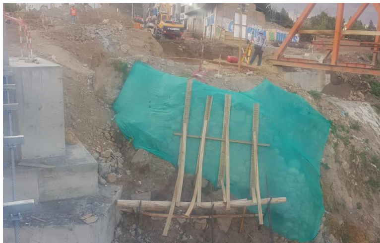
Figura N° 49 Muro pre-inca en la margen derecha del río
