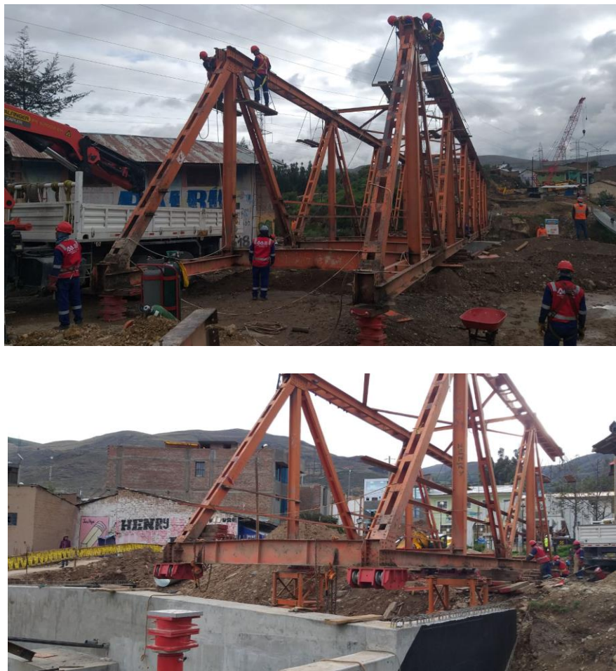
Figura N° 86 Finalización del desmontaje del antiguo Puente Chupuro
