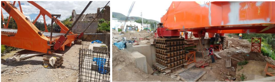
Figura N° 94 Fin del lanzamiento y posicionamiento final del puente
