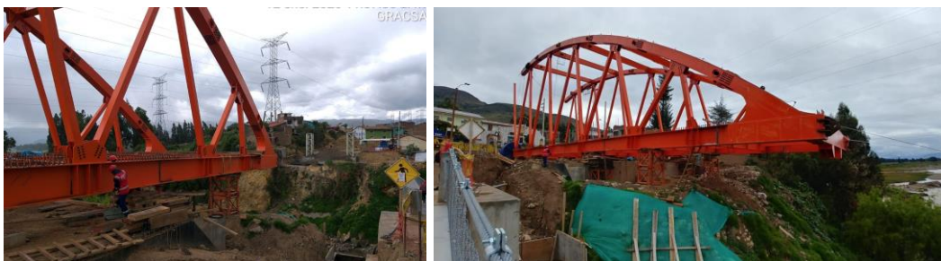
Figura N° 88 Montaje y lanzamiento típico del puente Chupuro
