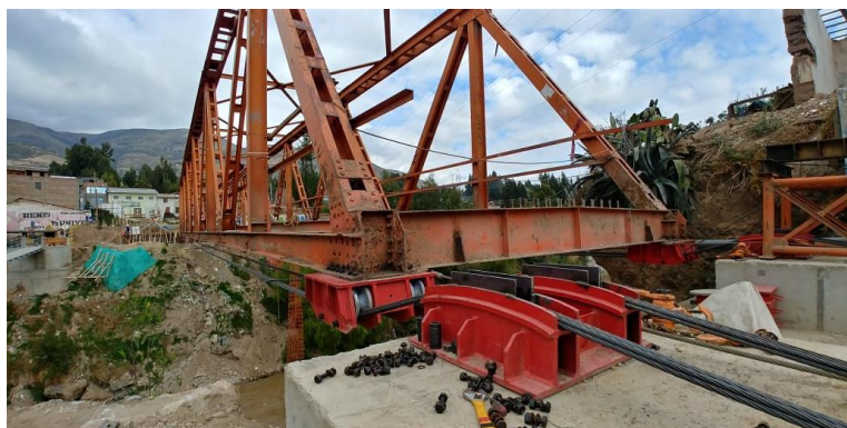
Figura N° 84 Apoyo de superestructura sobre cables
