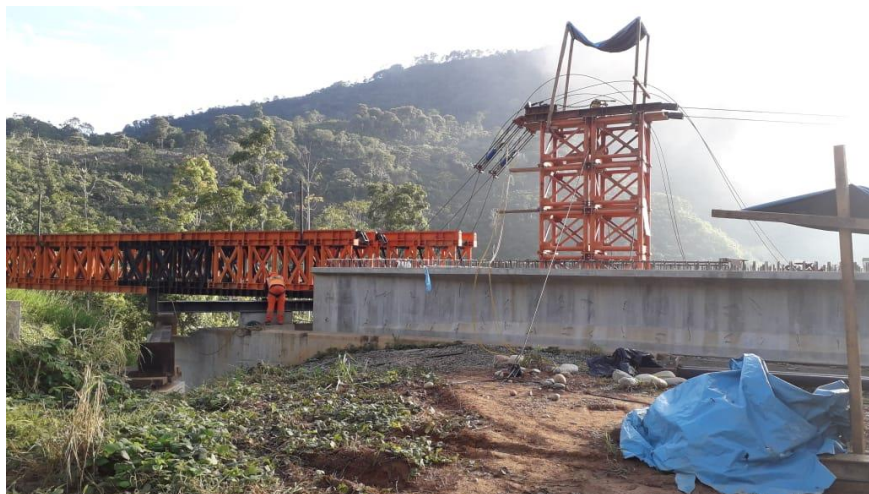
Figura N° 20 Lanzamiento de vigas metálicas mediante torre pescante – Puente Chavini
