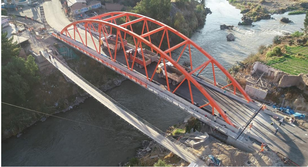
Figura N° 3 Puente Chupuro durante prueba de carga
