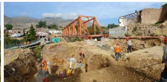
Figura N° 83 Montaje de cables de presfuerzo
