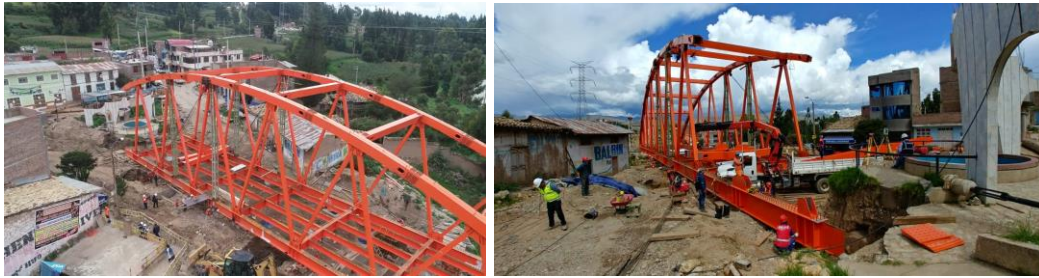
Figura N° 89 Montaje de castillos temporales para soporte de arco
