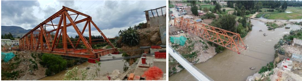
Figura N° 85 Lanzamiento inverso del Puente Chupuro
