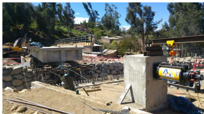
Figura N° 2 Lanzamiento del Puente Obraje – Región Ancash
