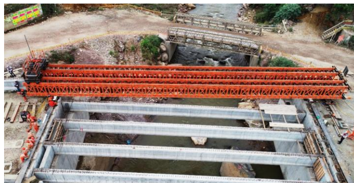
Figura N° 18 Vigas metálicas para el lanzamiento de vigas postensadas – Puente Chavini
