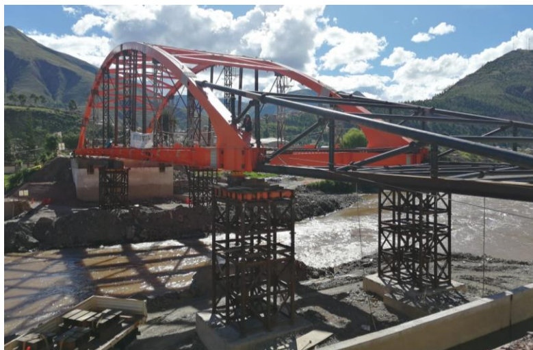
Figura N° 14 Lanzamiento con nariz - Puente Cusipata – Región Cusco
