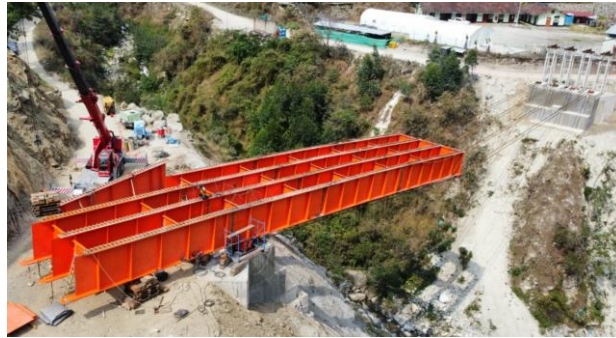
Figura N° 16 Lanzamiento del Puente Pampamarca
