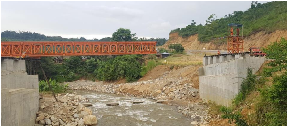
Figura N° 19 Lanzamiento de vigas metálicas mediante torre pescante – Puente Cubantía
