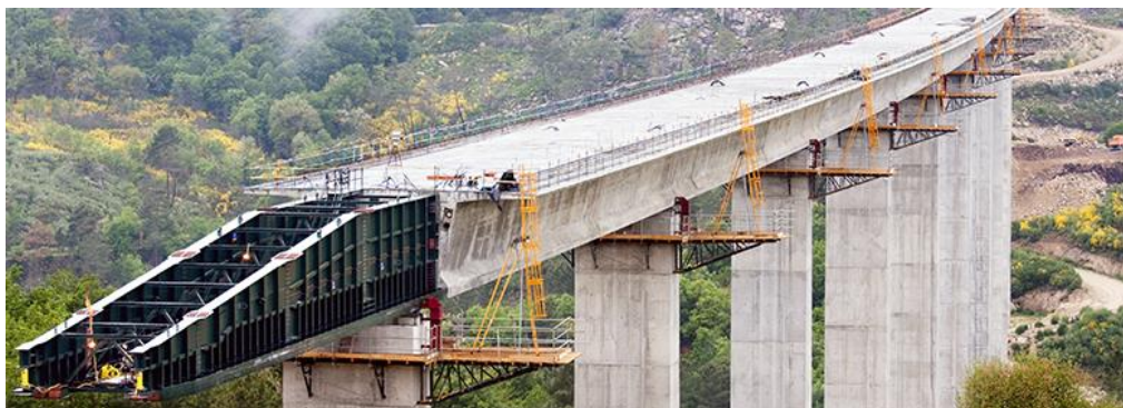
Figura N° 12 Lanzamiento incremental del Viaducto Barbantiño – España. Fuente: BBR PTE
