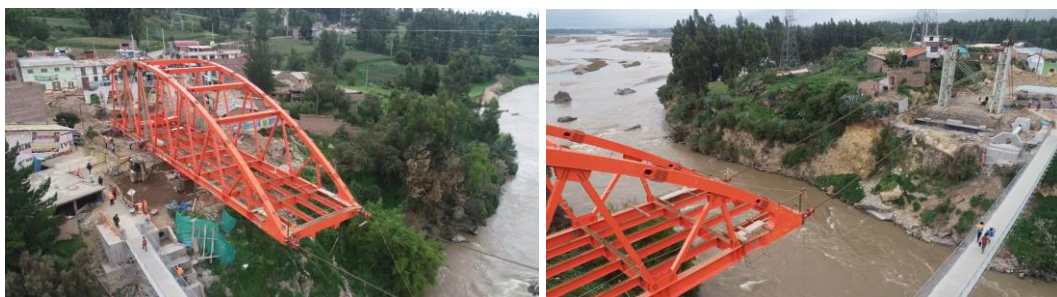
Figura N° 91 Montaje de cables de tiro del puente
