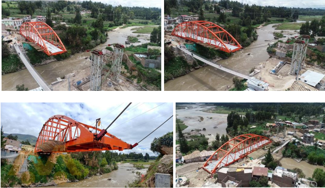
Figura N° 92 Lanzamiento mediante torre pescante
