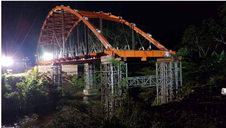
Figura N° 13 Lanzamiento del Puente Yanayacu – Región Huánuco
