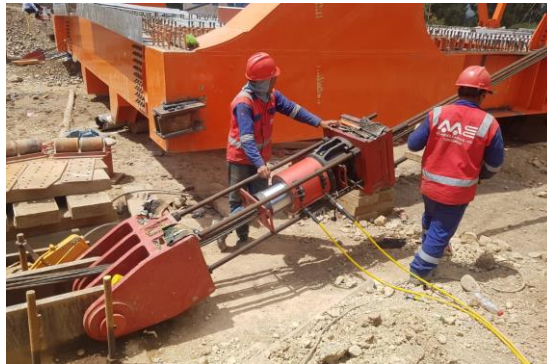
Figura N° 90 Montaje de retenida del puente
