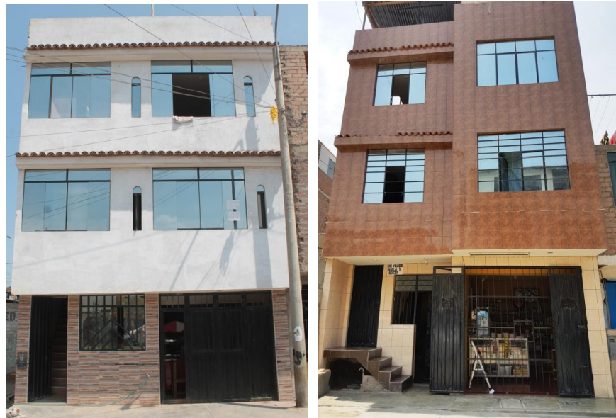
Figura 9. Arquetipo de albañilería en Perú
