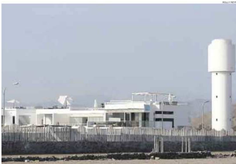
SIN FALLA. El abastecimiento de los clubes o condominios privados, con sus grandes tanques, como el de El Golf de Asia (en la foto), es de 24 horas al día.
