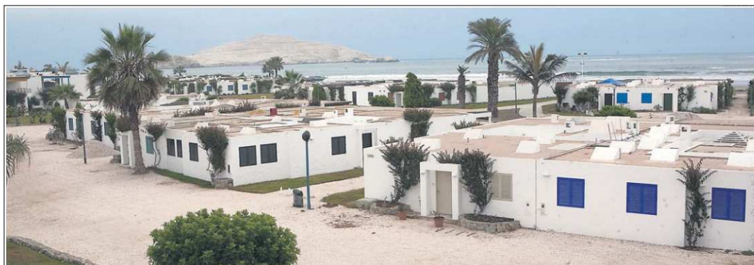
BAJO TIERRA. Por lo general, cada vivienda en el balneario de Asia, al sur de Lima, cuenta con un pozo séptico. A falta de redes de alcantarillado, los condominios han resuelto así la falta de desagüe.
