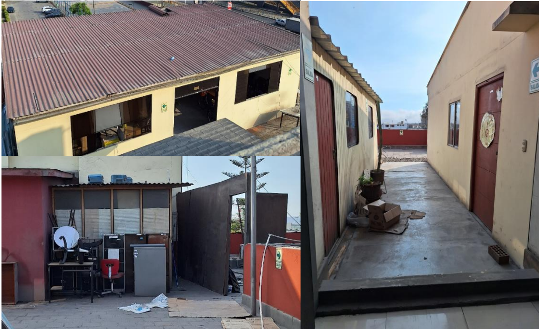
Fachada de tres áreas del Tercer Nivel.
