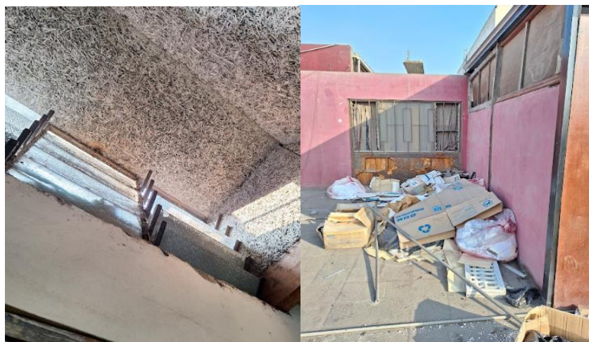
Fachada del área de archivo de abastecimiento del Cuarto Nivel.
