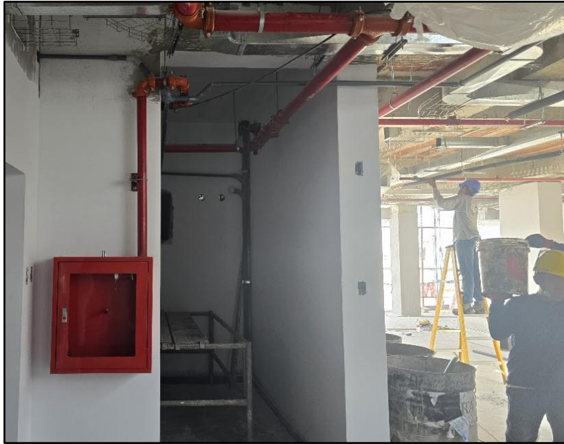
Instalación de gabinetes contra incendio
