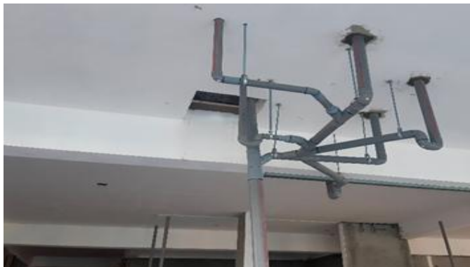
Imagen: Se lustra las tuberías de desagüe colgadas
