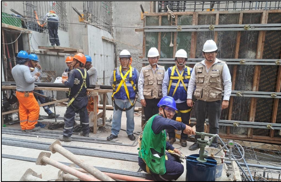
Prueba hidráulica de la red de agua fría
