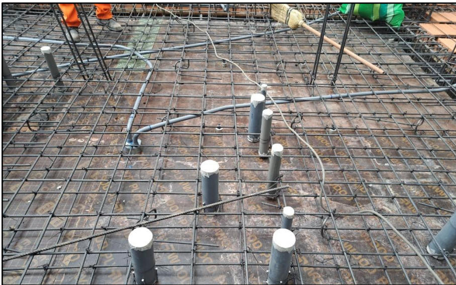
Liberación de pases de agua y desagüe en losa aligerada
