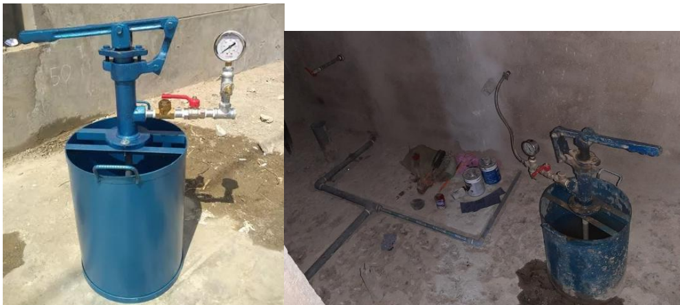
Imagen: Prueba hidráulica con balde
