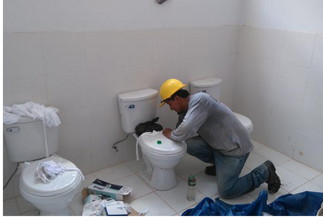
Imagen: Instalación de aparatos sanitarios
