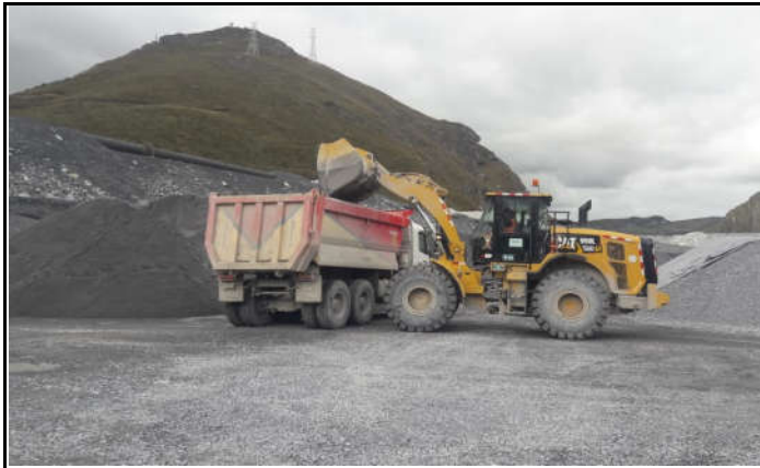
CARGUÍO DE MATERIAL 3B EN ACOPIO OHL
