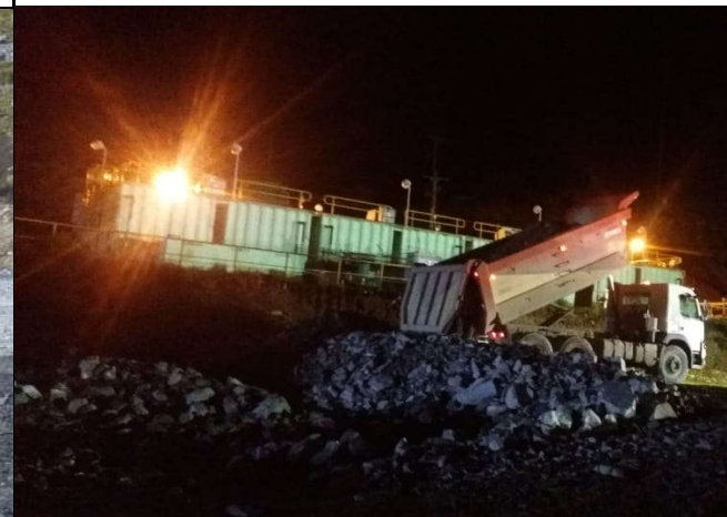
DESCARGA DE MATERIAL 3B DIQUE CORREDOR
