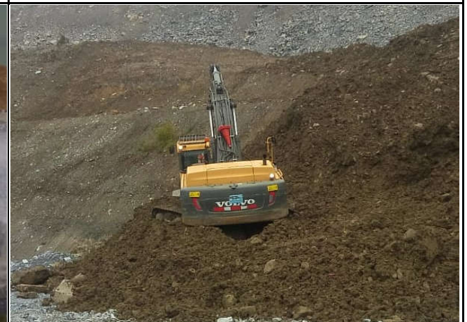
PERFILADO DE TALUD EN SECTOR 02 DEL DIQUE CORREDOR
