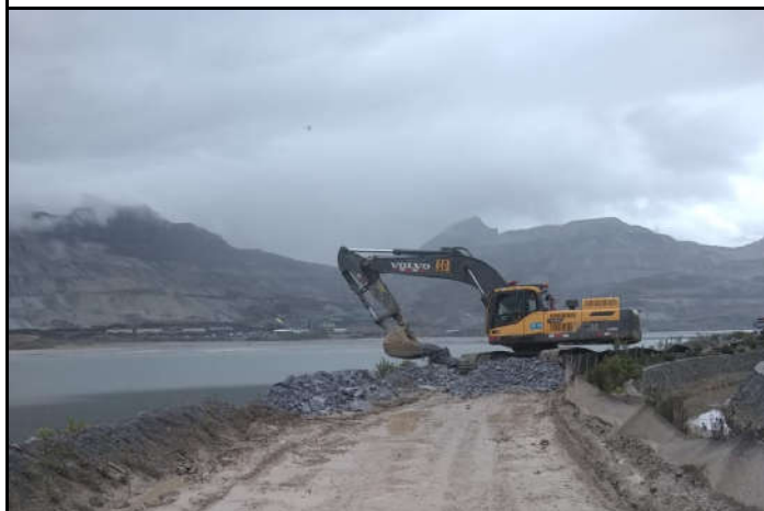
MANTENIMIENTO DE VÍAS HACÍA HUACACOCHA 2
