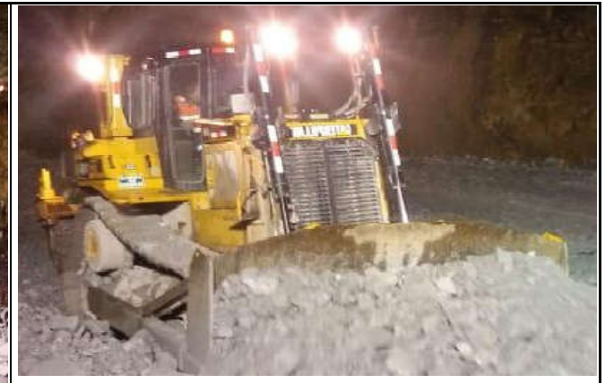
CONFORMACIÓN DE PLATAFORMA EN HUACACOCHA 2
