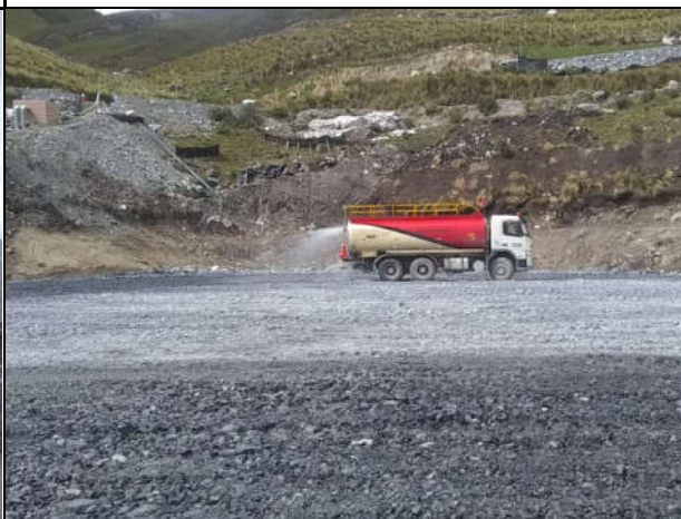
RIEGO DE PLATAFORMA EN DIQUE CORREDOR
