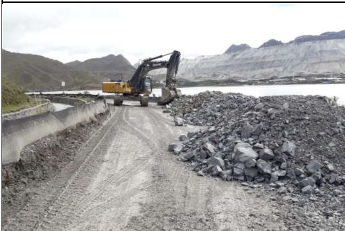
RECRECIMIENTO DE ACCESOS EN VÍA HUACACOCHA 2
