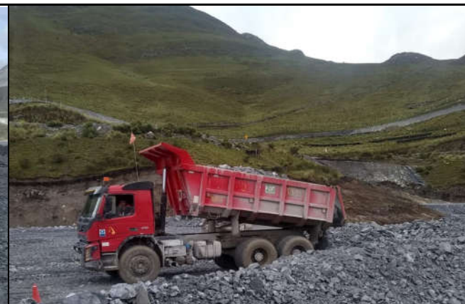
DESCARGA DE MATERIAL 3B
