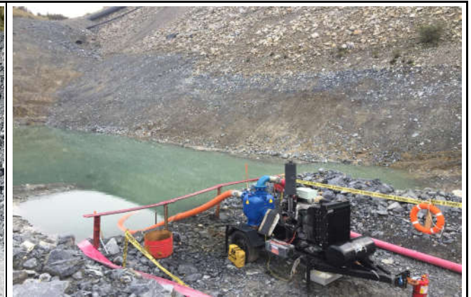
BOMBEO DE AGUA EN EL SECTOR 01 - DIQUE CORREDOR
