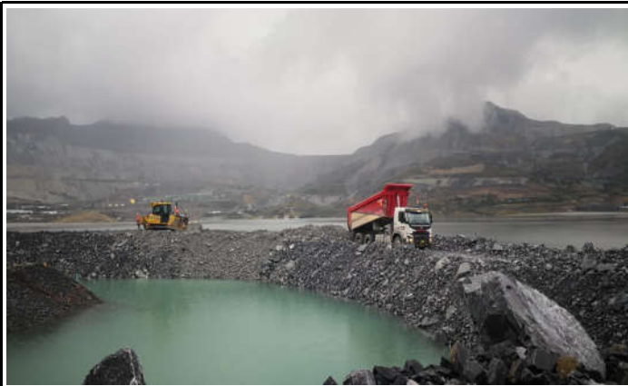
DESCARGA DE MATERIAL EN AMPLIACION DE ACCESO A HUACACOCHA
