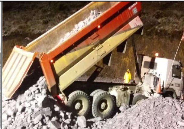
DESCARGA DE MATERIAL PARA CONFORMACIÓN PLATAFORMA - HUACACOCHA 2
