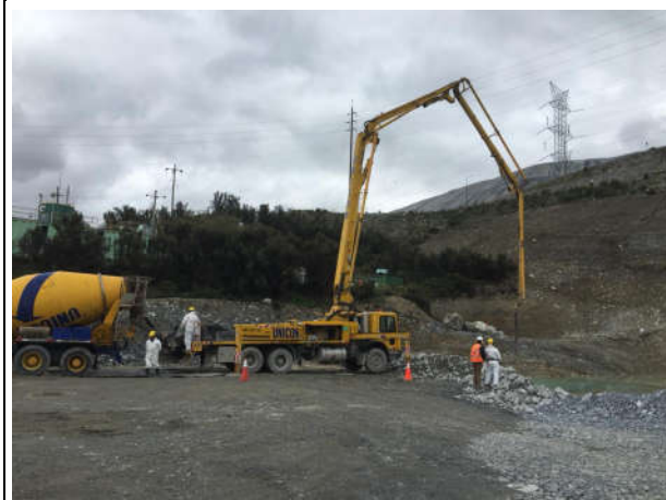
PANEL TEST DE CONCRETO EN SECTOR 02 DEL DIQUE CORRDROR
