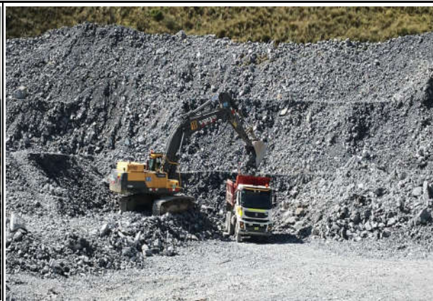
CARGUIO DE MATERIAL LASTRE PARA ACCESO EN HUACACOCHA
