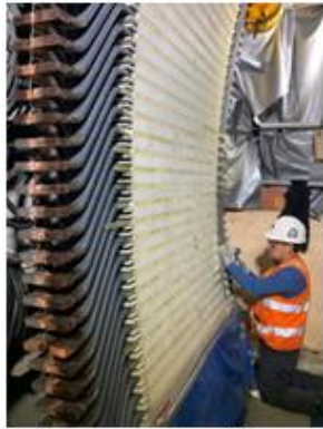
Reacufiando de ranuras del nuevo estator
