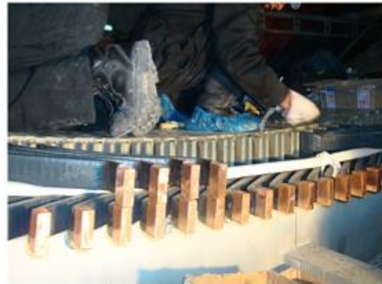
Instalación de barras superiores
