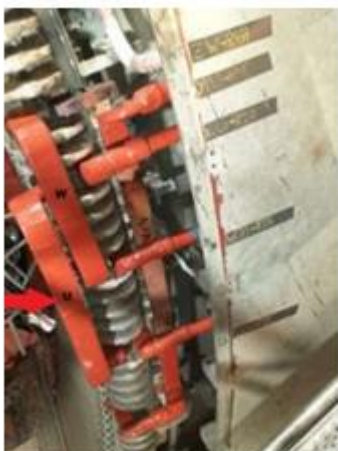
Encintado de conexiones nuevas
