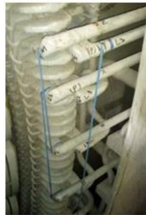
Identificación de conexiones originales
