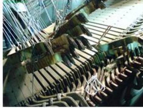
Levantamiento de barras superiores
