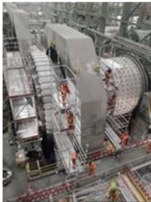
Armado de andamios alrededor del rotor
