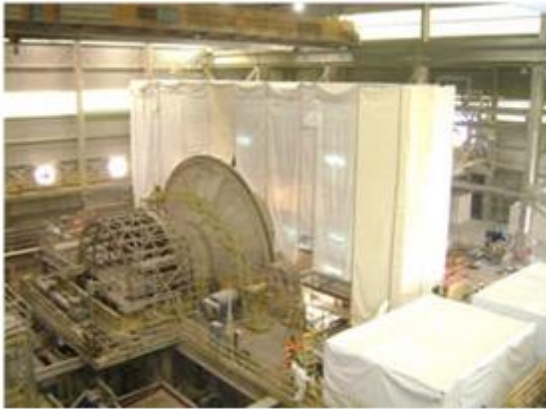
Estructura de andamios y cubiertas para encerramiento de lugar de trabajo
