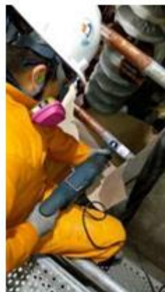
Corte de conexiones originales
