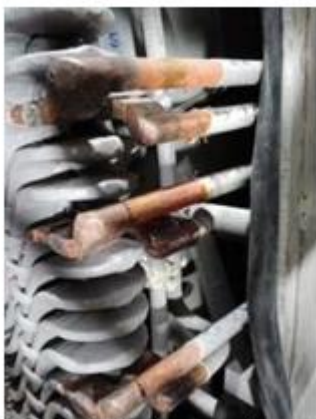
Retiro de aislamiento de conexiones originales
