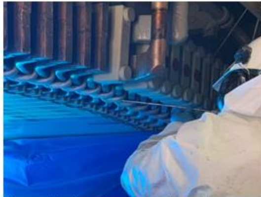
Inyección de resina en cordones de arrame
