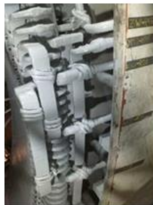
Aplicación de esmalte antiflash a conexiones nuevas
