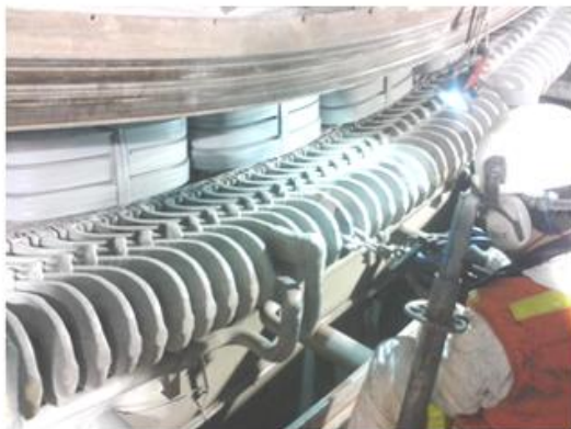
Desoldado de uniones de cabezas de bobinas
