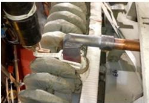
Soldadura de conexión nueva "X"
