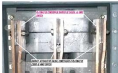
Conexiones de línea original
