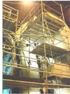
Andamiaje para acceder a bobinado
