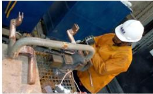
Recuperación de conexiones retiradas
