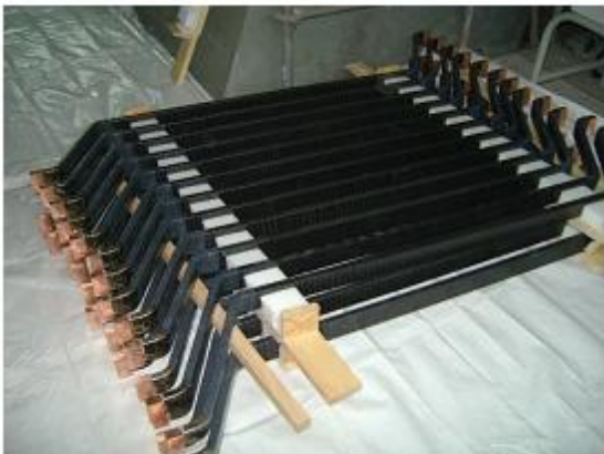
Barras nuevas con proceso VPI
