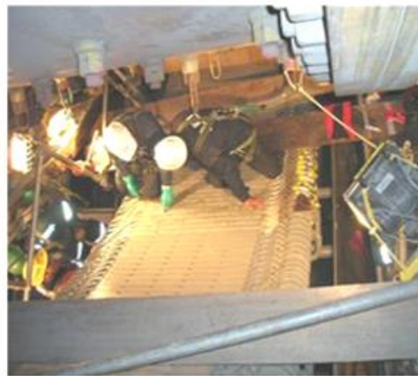
Retiro de cuñas de ranuras
