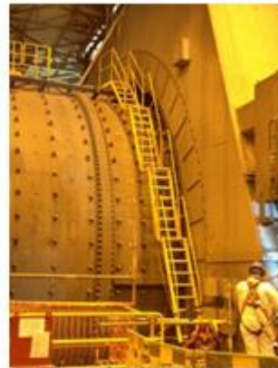
Escaleras para acceso al estator
