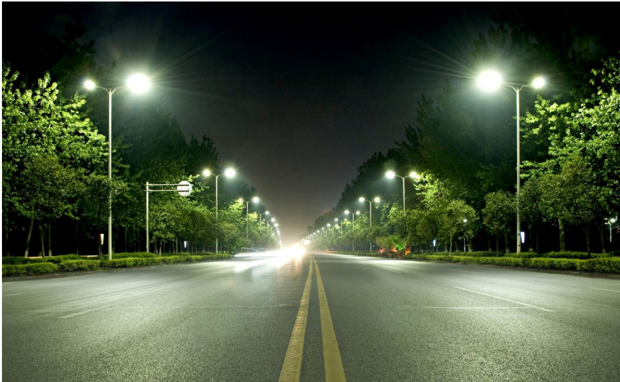
Iluminación de tipo LED en Vía Pública
