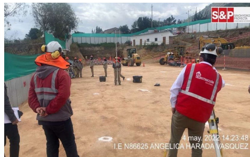
Verificación de niveles cota final 2513.15 msnm – plataforma 01-Sector 03.
