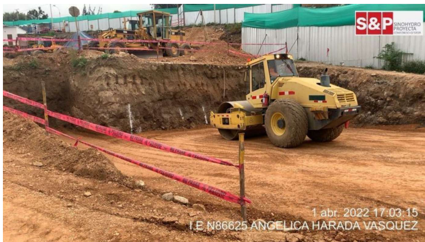
Trabajos de estabilización en zona saturada PLT-02.
