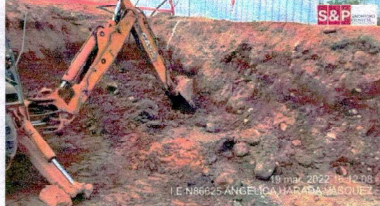
Sabado 19-03-22, Verificacion de humedad y area saturada en la zona sur de la plataforma 02 junto al canal éste y canal sur exterior
