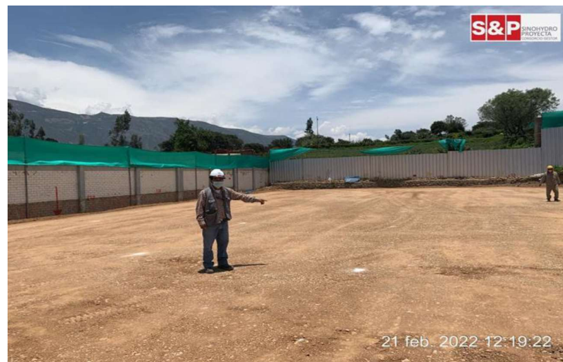
Conformación de la capa 01 de la plataforma 01 (pabellón demolido) y de la PLT. 3-4 la capa 04.
