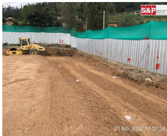
Capa de relleno en zona saturada y pozo séptico.
