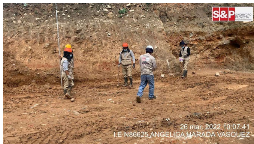
Trabajos de plantillado en la plataforma 01 – extracción de muestras para análisis.
