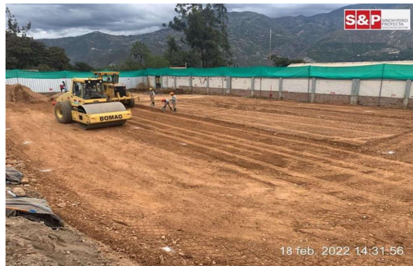
Trabajos de compactada plataforma 01 Pab. Demolido – Plataforma 04, 03.
