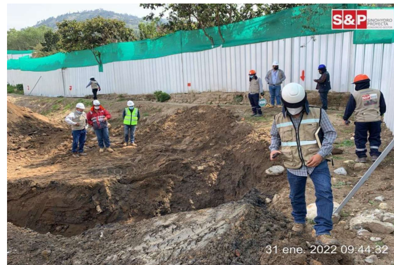
Visita del Especialista, el motivo identificar si el material necesita un reemplazo del estrato completo por temas de humedad o suelo inadecuado -plataforma 3 y 4.
