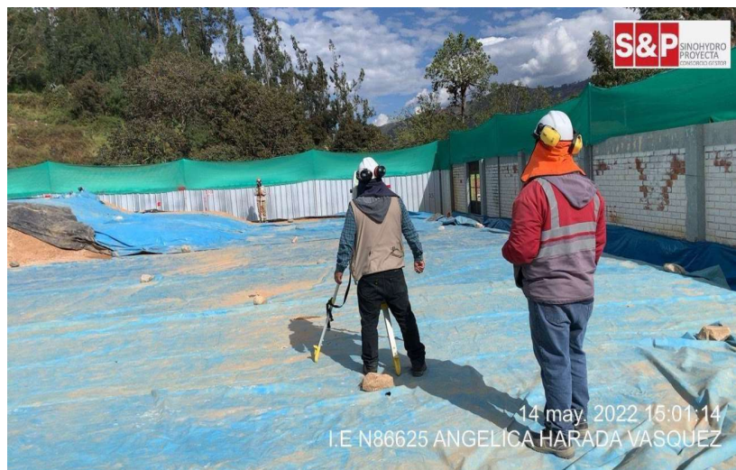
Verificación y recepción topográfica PLATAFORMA 04 Y 03.
