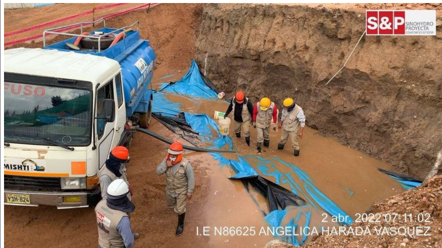
Actividades de retiro de agua, específicamente en el área saturada en la plataforma 02.
