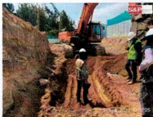
Inspeccion – PAB. DEMOLIDO – PLT 1
