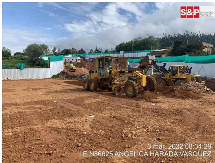
Capa 06 de las plataformas 03-04, batido y plantillado.
