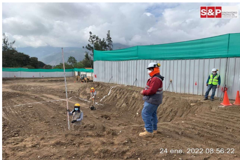
Exploración con calicatas PLT 4-3 – Trazo Pabellón demolido.
