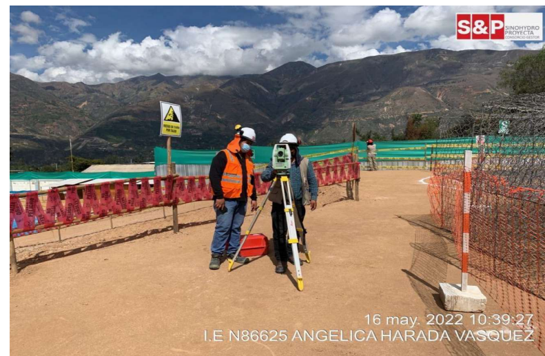
Verificación y recepción topográfica plataforma 02 Y 01.
