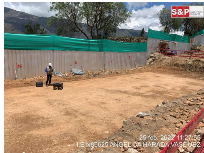
Se Libera la capa06 de la PLT.01 del Pabellón demolido.
