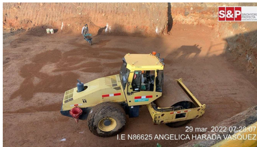
Liberación de la capa 01/ final de la plataforma 01 – 2513.65 msnm
