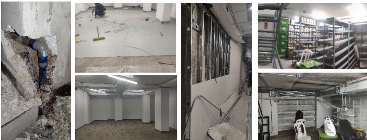
Figura 85. INK JULIACA 01 – Avance de obra
