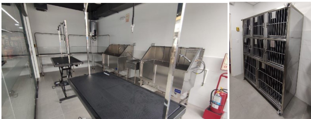
Figura 65. SP 40 CHACARILLA – Acondicionamiento del área de Grooming.
