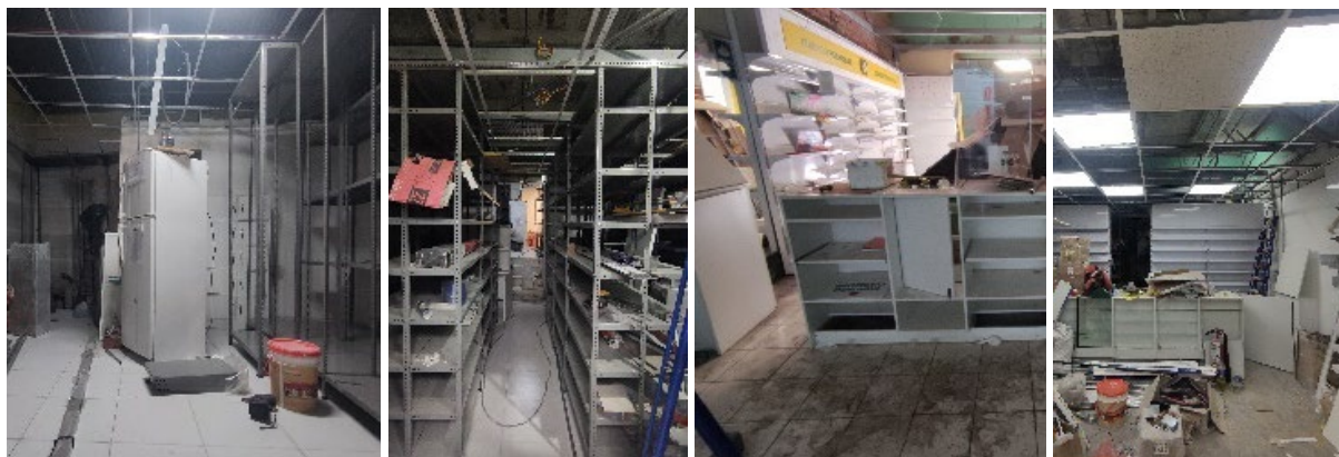
Figura 75. INK PUNO 01 – Avance de obra
