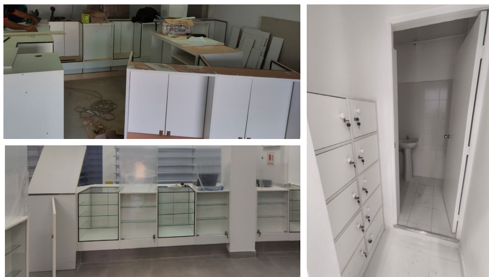
Figura 148. INK 571 CHICLAYO – Instalación de mobiliarios
