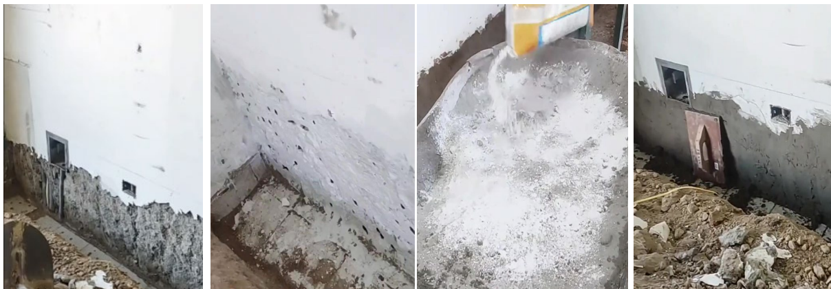
Figura 135. INK 571 CHICLAYO – Impermeabilización de muros
