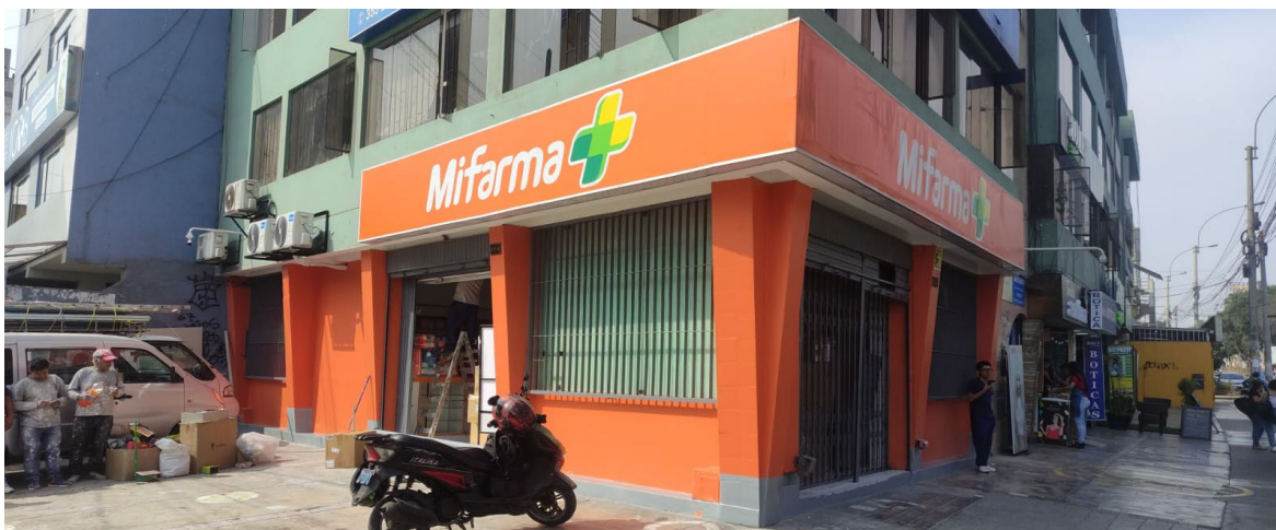
Figura 52. MIF 097 ROSA TORO – Intervención en fachada
