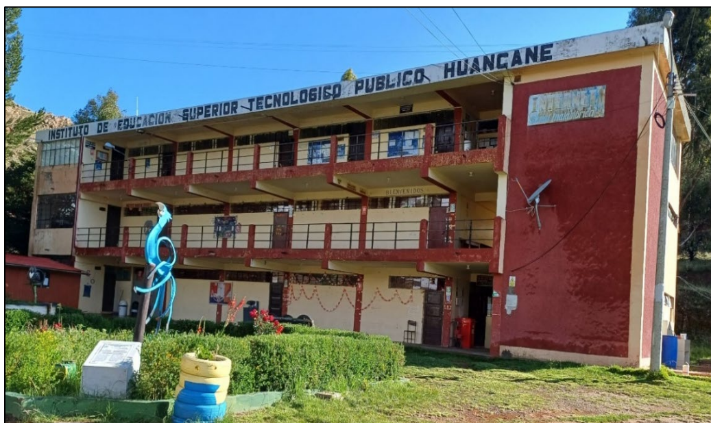
Figura 156. IESTP HUANCANÉ – Actual infraestructura del IESTP HUANCANÉ
