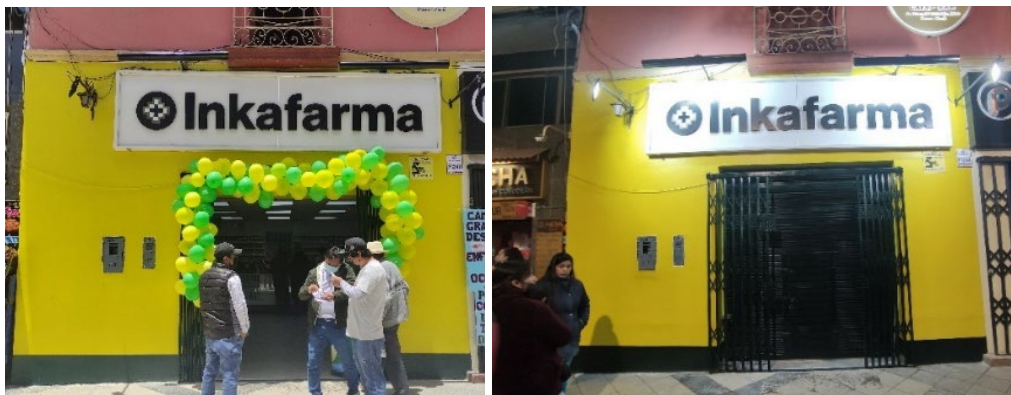
Figura 80. INK PUNO 01 – Intervención en fachada
