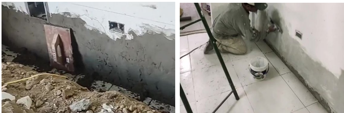
Figura 132. INK 571 CHICLAYO – Reparación de muros
