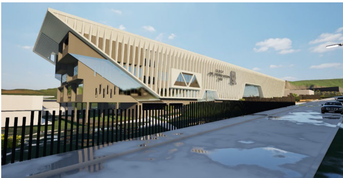
Figura 11. IESTP JOSÉ ANTONIO ENCINAS – Fachada del bloque principal
