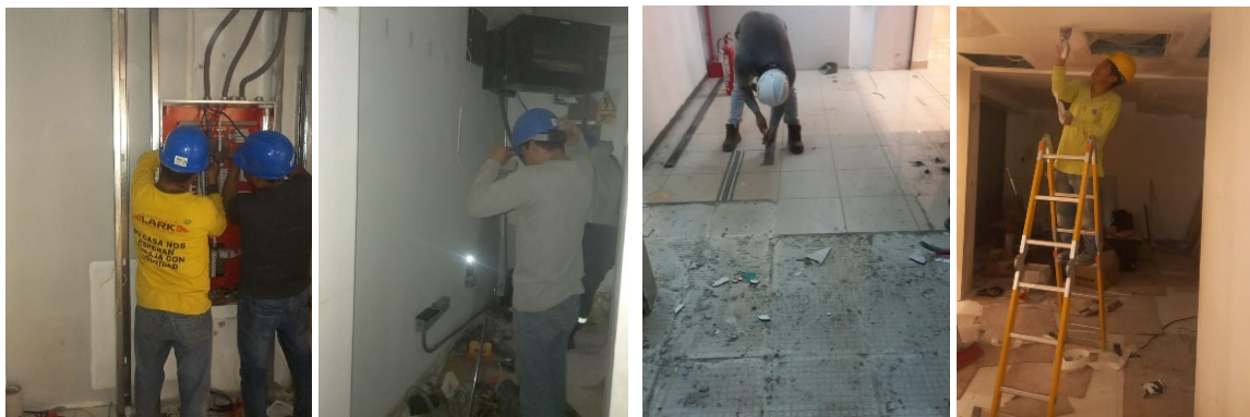
Figura 25. INK 208 PV CHACARERO – Avance de obra
