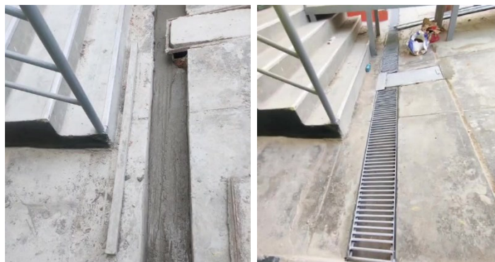
Figura 137. INK 571 CHICLAYO – Construcción de canal de drenaje
