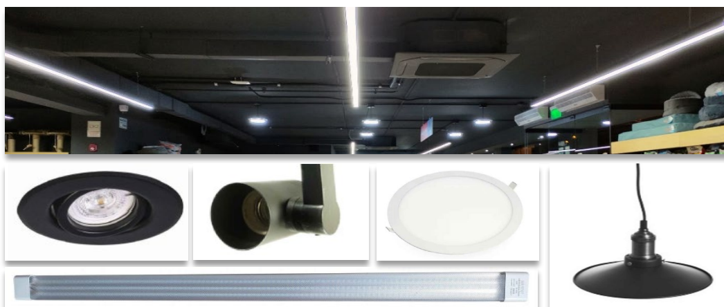
Figura 112. SP40 CHACARILLA – Instalación de luminarias
