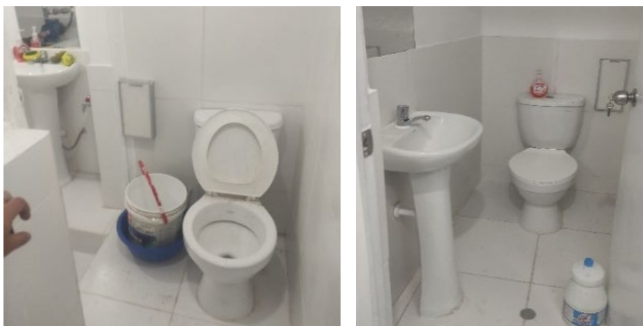
Figura 94. INK JULIACA 01 – Renovación de los servicios sanitarios
