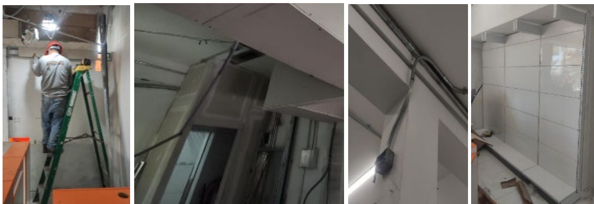
Figura 50. MIF 097 ROSA TORO – Avance de obra
