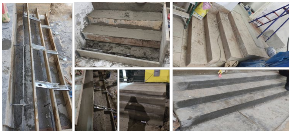
Figura 134. INK 571 CHICLAYO – Construcción de graderías
