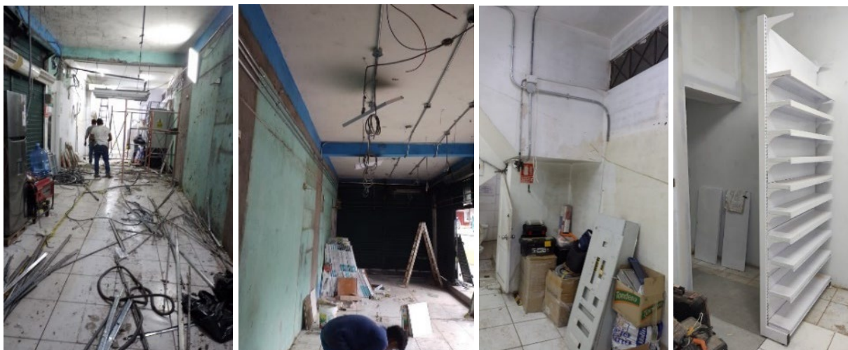
Figura 68. INK 303 AGUAYTIA – Avance de obra
