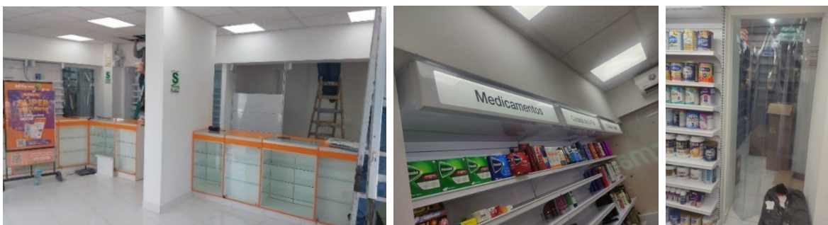
Figura 53. MIF 097 ROSA TORO – Renovación del área de ventas
