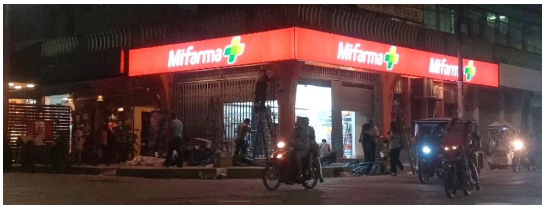
Figura 36. MIF T05 SATIPO – Intervención en fachada
