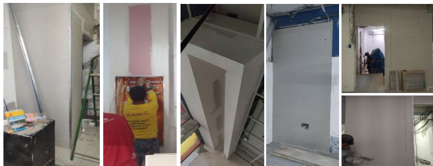
Figura 139. INK 571 CHICLAYO – Construcción en sistema drywall
