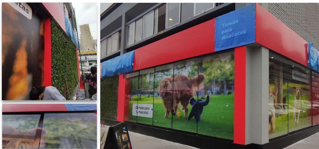
Figura 113. SP40 CHACARILLA – Instalación de Mamparas y letreros
