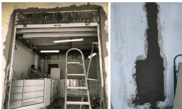
Figura 138. INK 571 CHICLAYO – Trabajos de albañilería
