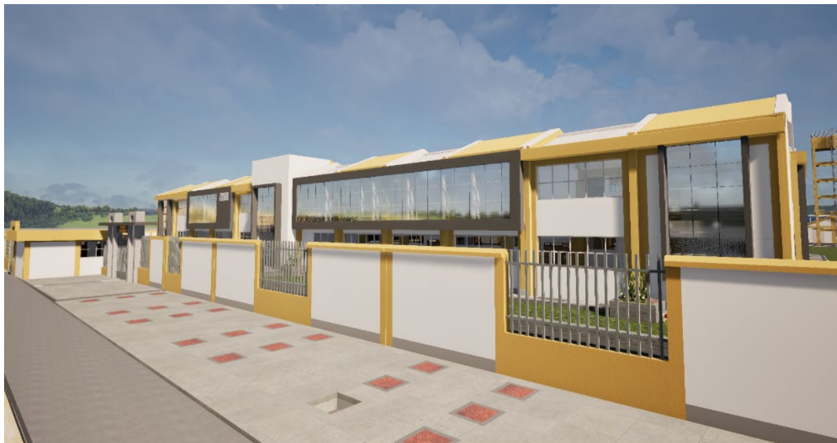
Figura 174. IESTP HUANCANÉ – Vista de ingreso principal
