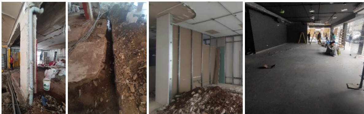
Figura 57. SP 40 CHACARILLA – Avance de obra
