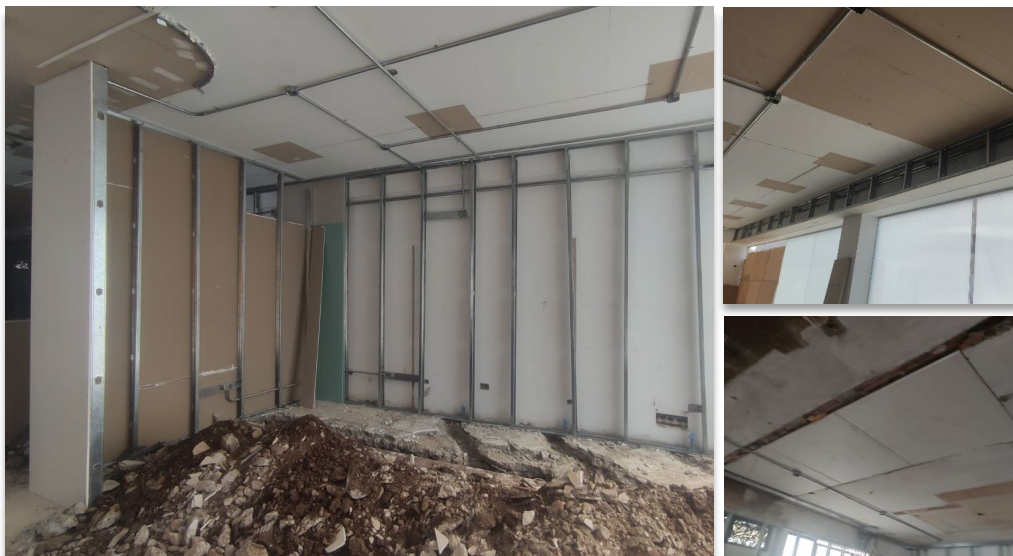
Figura 109. SP40 CHACARILLA – Tabiquería en sistema drywall
