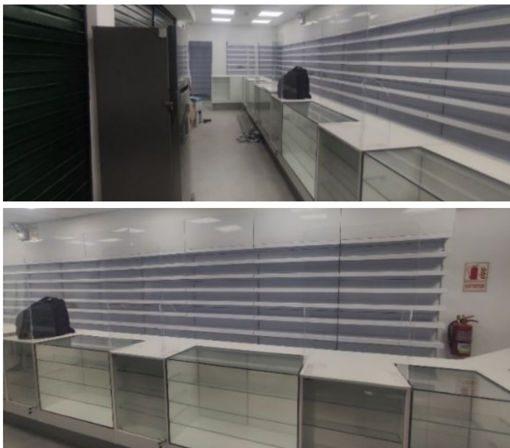
Figura 70. INK 303 AGUAYTÍA – Renovación del área de ventas
