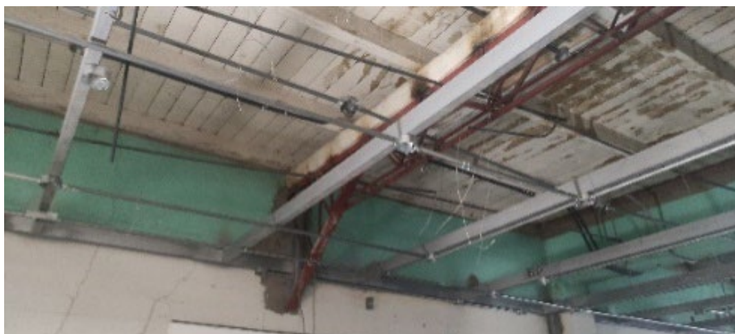
Figura 82. INK PUNO 01 – Ejecución de solución estructural para FCR
