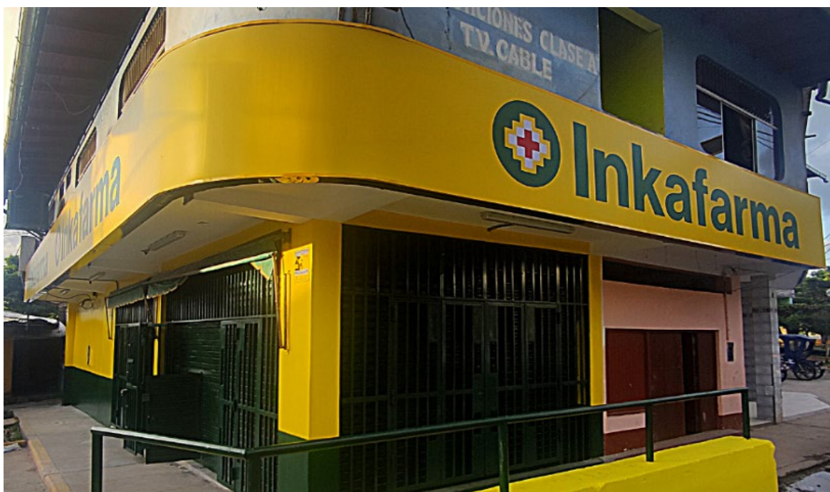
Figura 71. INK 303 AGUAYTÍA – Intervención en fachada
