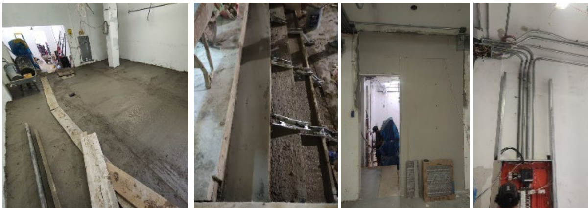
Figura 41. INK 571 CHICLAYO – Avance de obra
