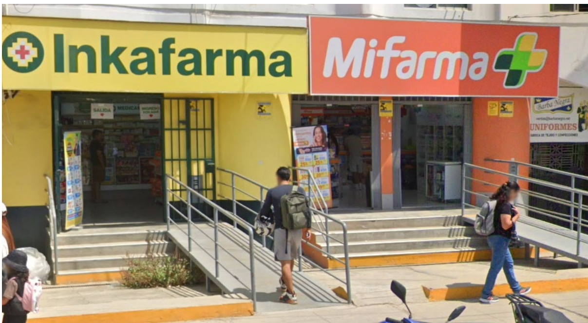
Figura 39. INK 571 CHICLAYO – Rehabilitación del local
