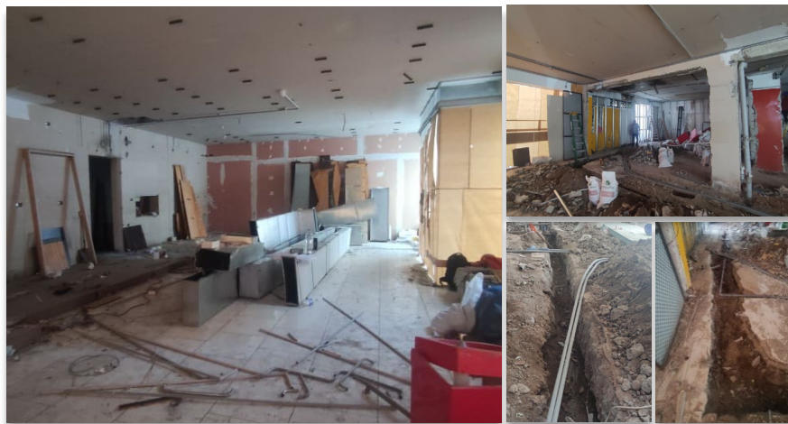
Figura 105. SP40 CHACARILLA – Trabajos preliminares
