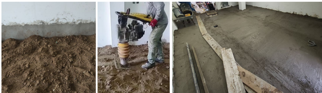
Figura 136. INK 571 CHICLAYO – Construcción de piso elevado
