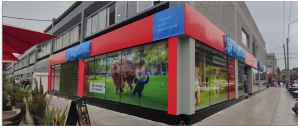
Figura 117. SP40 CHACARILLA – Fachada PJ. MONTE AZUL
