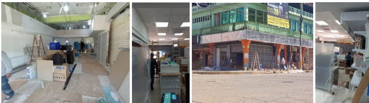
Figura 33. MIF T05 SATIPO – Avance de obra
