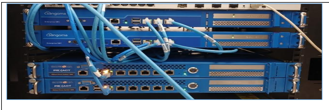
Figura 10: Appliance físico rackeado en el DC del MINCETUR y están implementados en alta disponibilidad.
