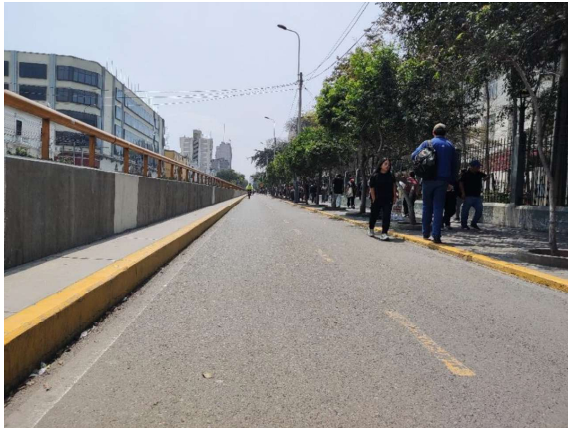
Ciclovía Avenida Garcilazo de la Vega Tramo 1
