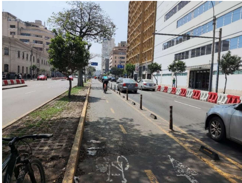
Ciclovía Avenida Garcilazo de la Vega Tramo 3
