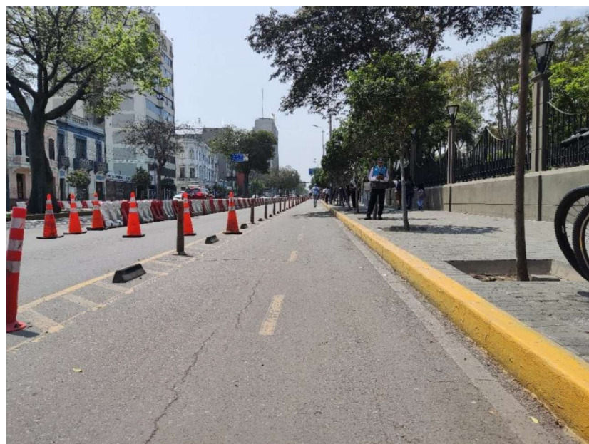
Ciclovía Avenida Garcilazo de la Vega Tramo 2
