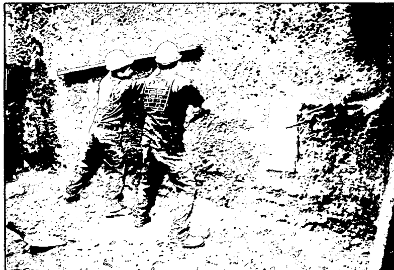
Fotografía 4.36 Perfilado y alisamiento de superficie
