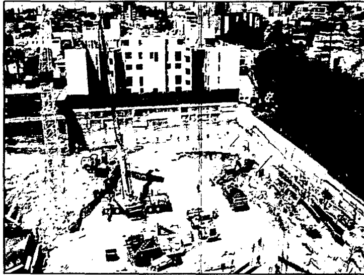
Fotografía 4.05 Excavación masiva
