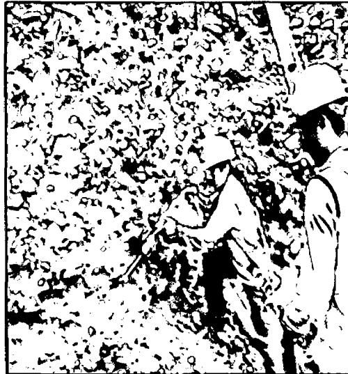
Fotografía 4.10 Perfilado con martillo
