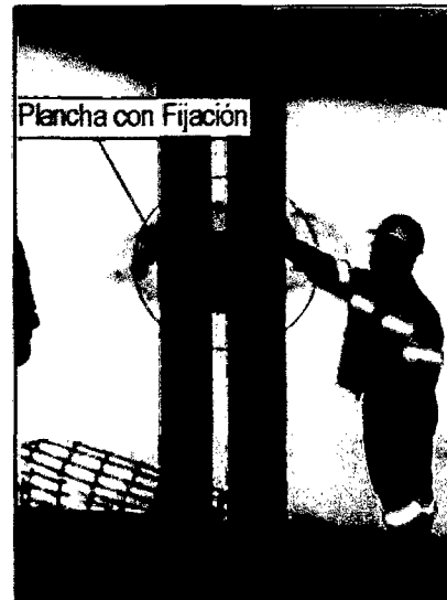
Fotografía 4.34 Columnas de Acero con Planchas de Fijación.
