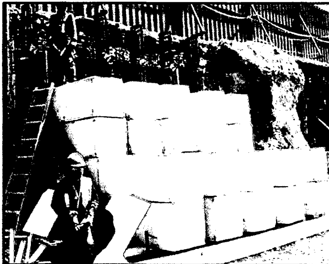
Fotografía 4.32 Encofrado Dependiente de la Fuerza de Rozamiento
