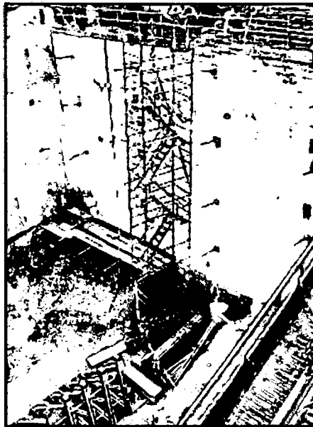
Fotografía 4.03 Uso de Escalera en andamio
