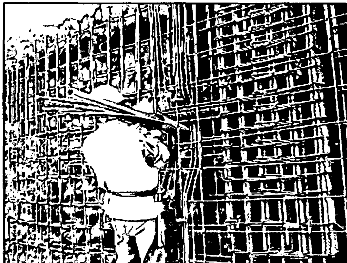
Fotografía 4.22 Colocación de protección con tubería PVC.
