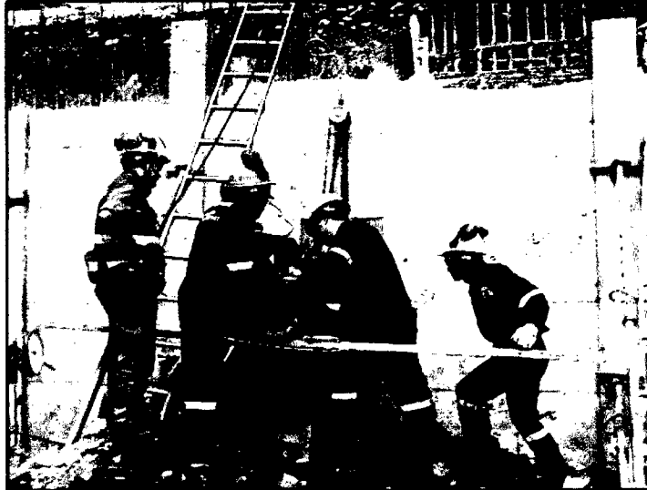
Fotografía 4.13 Tensado del Cable de anclaje.
