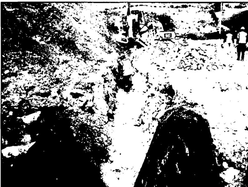
Figura N°6.5 Daños en la excavación para subdren por lluvias
