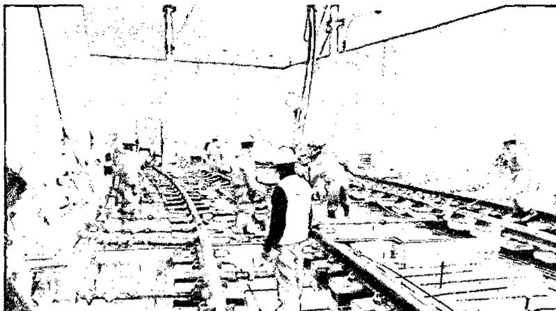
Figura N° 4.20: Preparación e inicio del vaciado de concreto de 350kg/cm<sup>2</sup> en cola de vía
