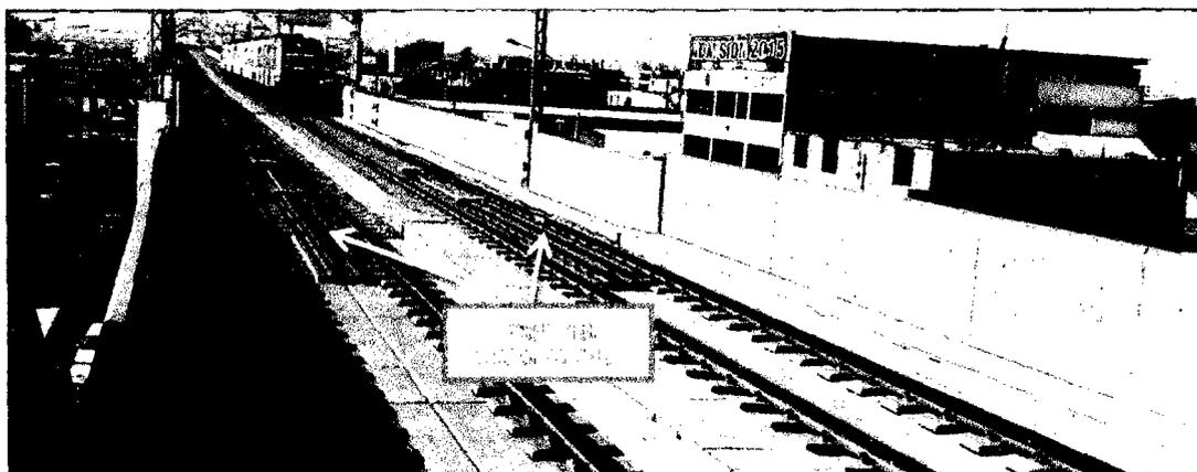
Figura N° 4.28: Transición de sistema sonneville a vía balastada.
