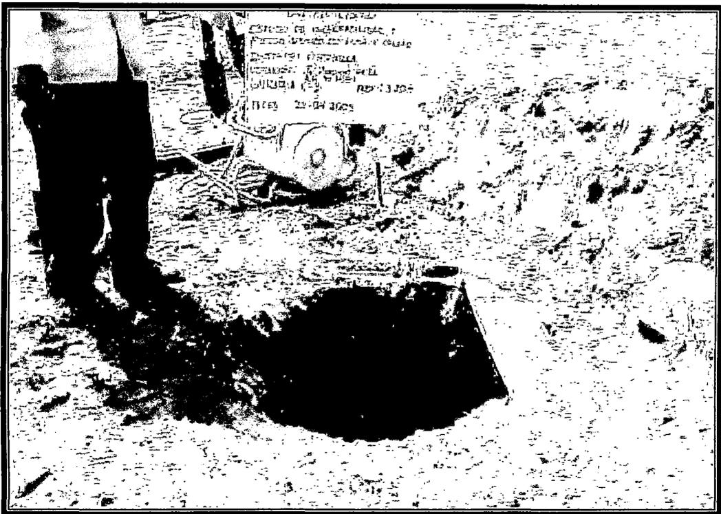
**Foto 1.** Calicata de exploración C01 de 3.0m de profundidad, ubicada en el A.H. Mi Perú MZ D1, frente al lote 11. Hasta la profundidad explorada se encontró arena.
