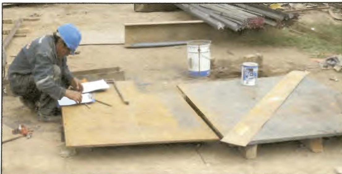
Fig. 5.2 Trazado de cartelería, accesorios para conexión
