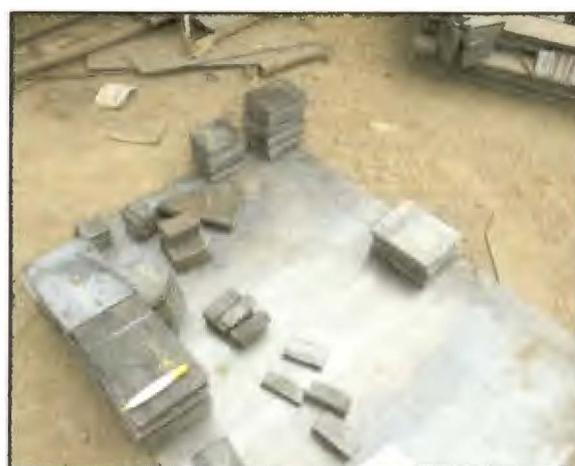
Fig. 5.3 Habilitado de plancha y cartelería
