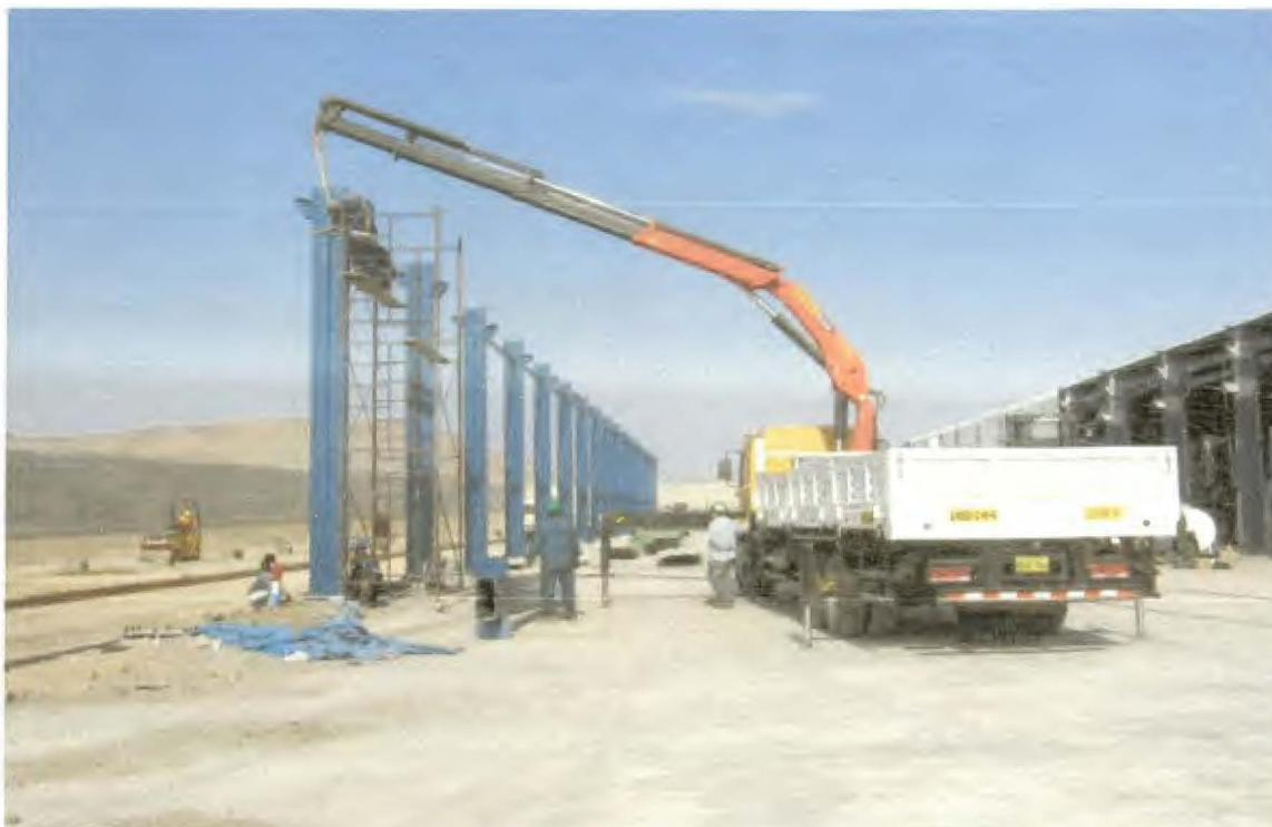
Fig. 6.2 Montaje de columnas y puntales
