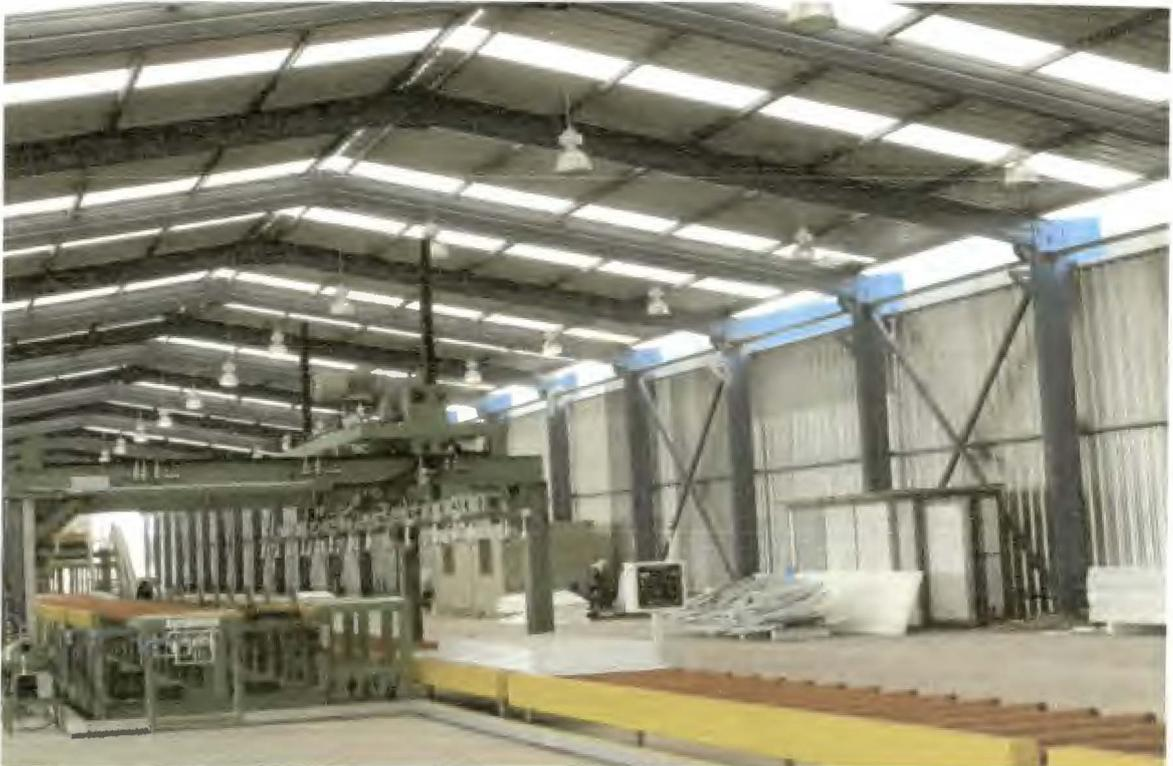
Fig. 2.8 Nave industrial de marco rígido con sección Tubest
