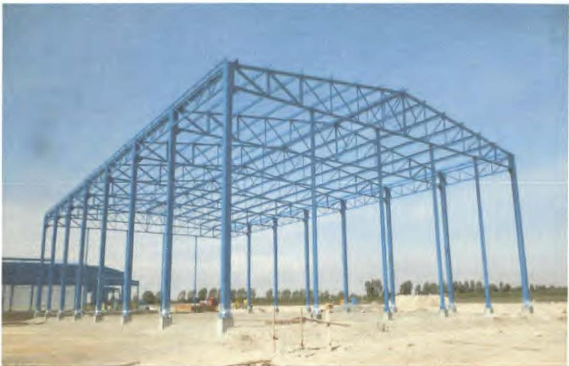
Fig. 2.9 Nave industrial de marcos compuestos por armaduras y columnas
