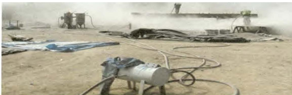
Fig. 5.11 Aplicación de arena a presión. Tratamiento superficial SSPC SP5
