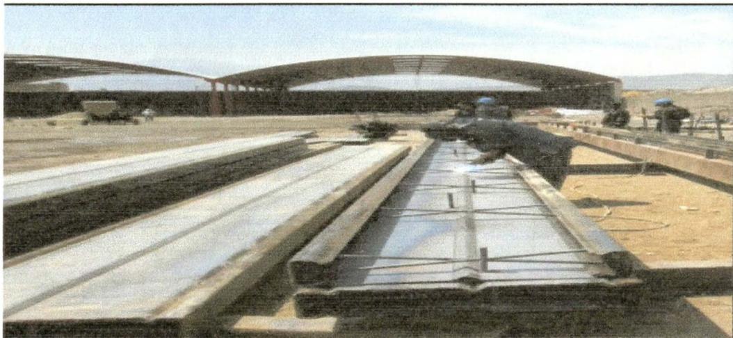
Fig. 5.4 Fase intermedia donde se arman las vigas y columnas compuesta de sigma y ohm, y se suelda las uniones para tener un tubo cajón.
