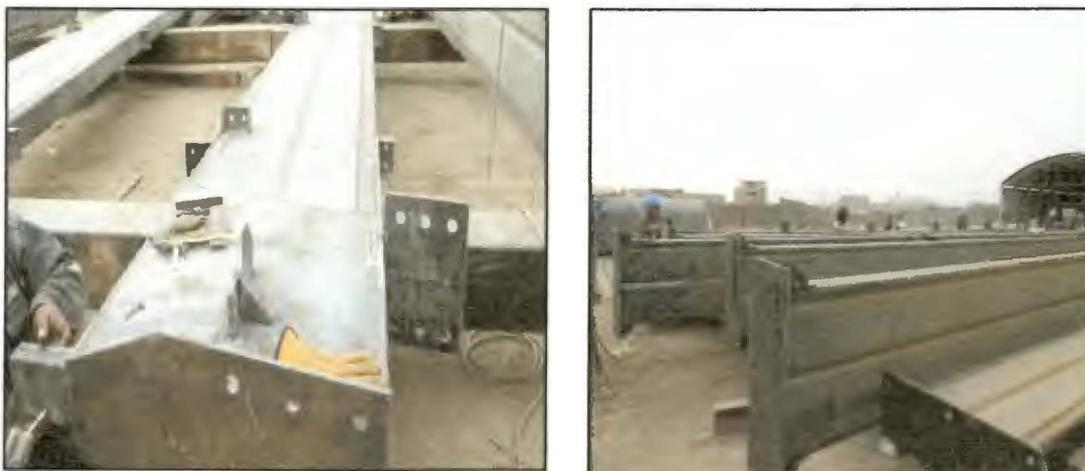
Fig. 5.5 Armado de columnas y vigas, instalación de accesorios
