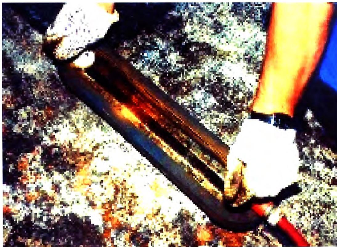
**Figura 4.25 Prueba de vacío a las uniones de soldadura de las plancha del fondo de un tanque**
