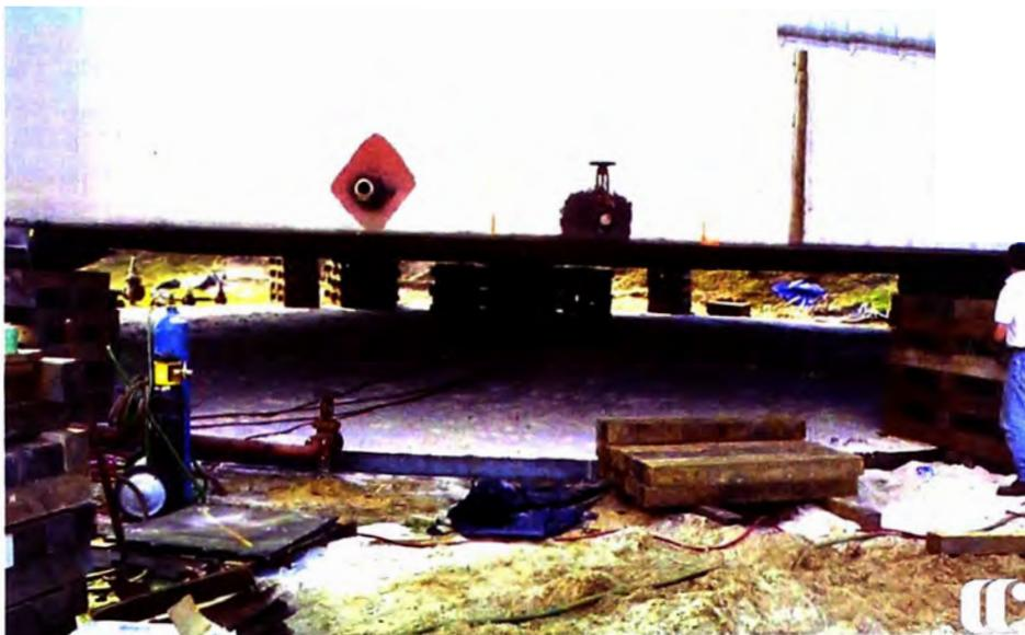
**Figura 4.29** Tanque izado para la ejecución del reemplazo del fondo
