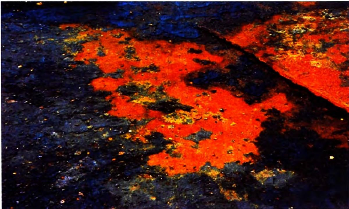
**Figura 4.7 Fondo de tanque en proceso de limpieza con presencia de costras**
