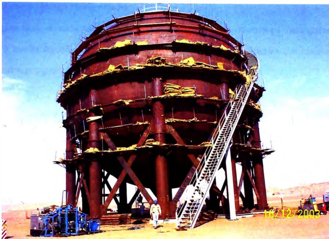
**Figura 2.7 Tanque esférico de alta presión en proceso de construcción para el almacenamiento de Gas Licuado de Petróleo (propano, butano)**
