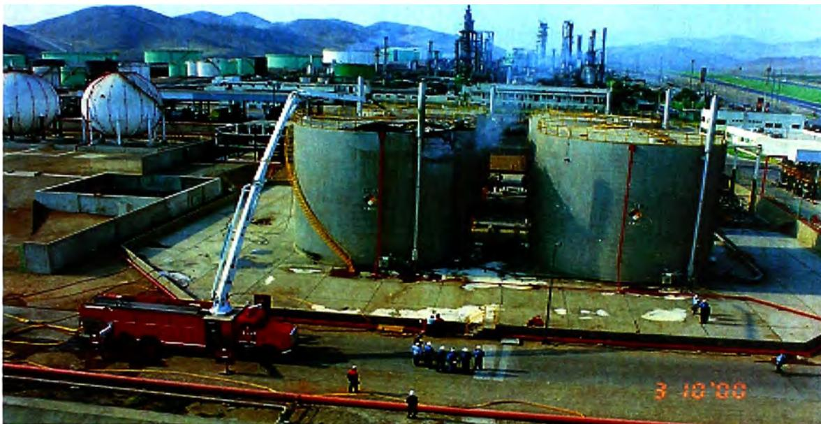
**Figura 2.9 Tanques con aislamiento sobre toda su superficie para mantener el calor de su interior**
