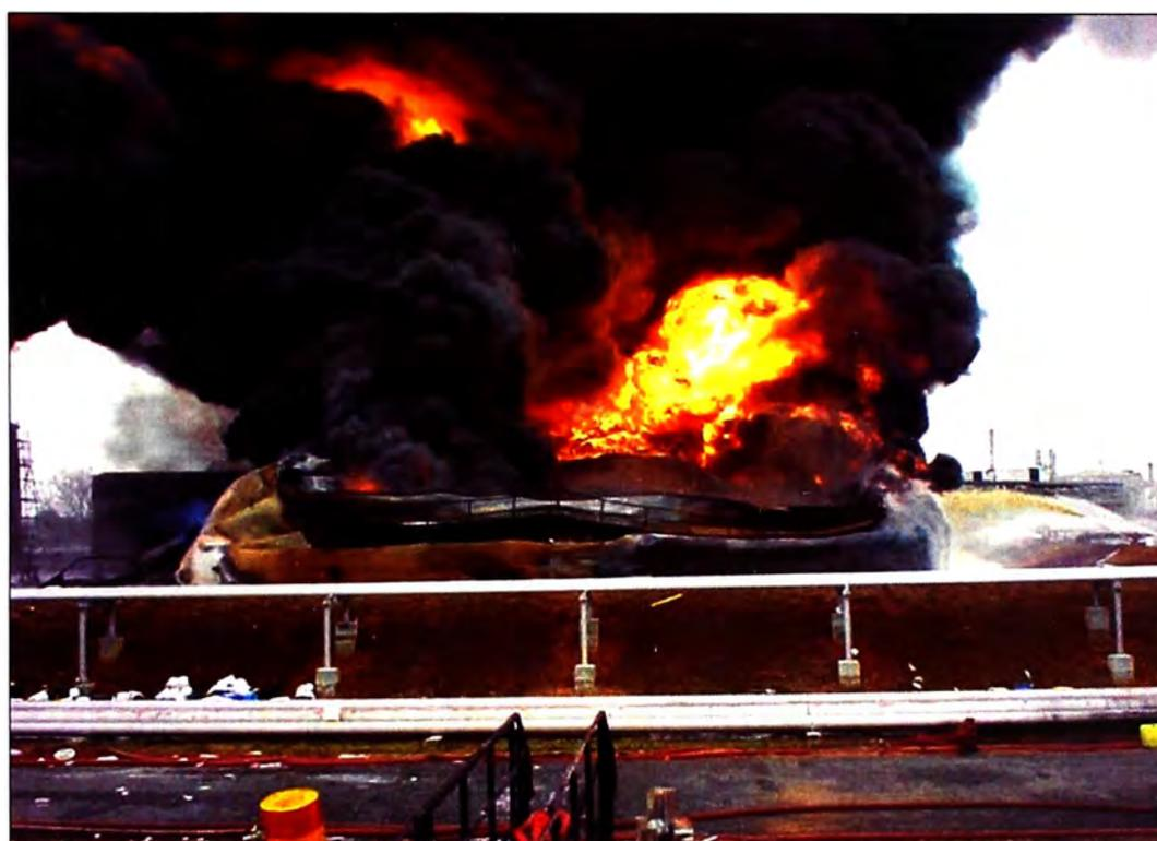
Figura 2.12 Tanque incendiado, colapso del tanque por el calor del fuego.
