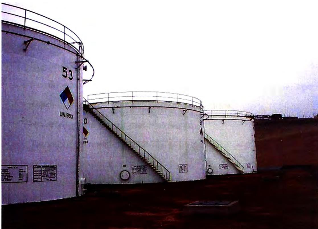
**Figura 2.10** Típico patio o zona de tanques para el almacenamiento del petróleo y sus derivados en una Planta de Abastecimiento o Refinería.
