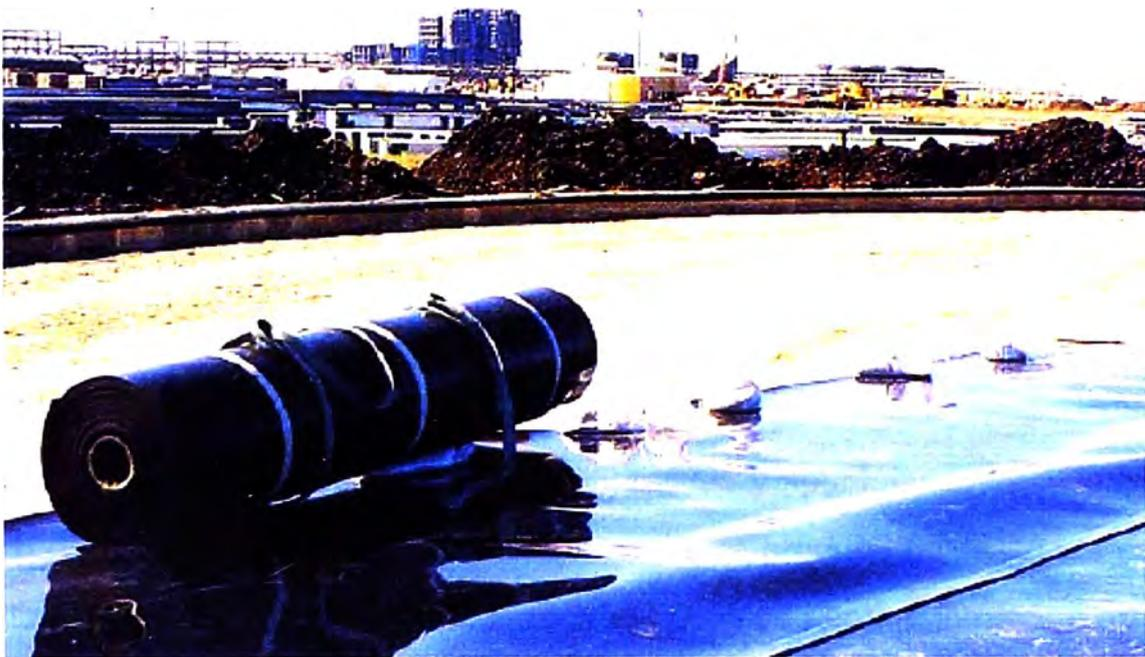
**Figura 4.31 Instalación de geomembrana impermeable en el fondo del tanque**
