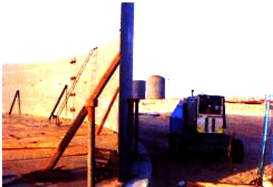
**Figura 2.24 Erección del primer anillo del tanque**
