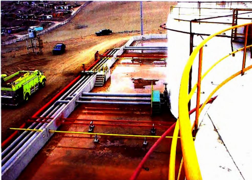
**Figura 2.36 Muro de contención tipo pared impermeabilizada**
