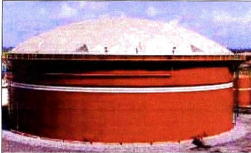
Figura 2.2 – Tanques de techo auto soportado
