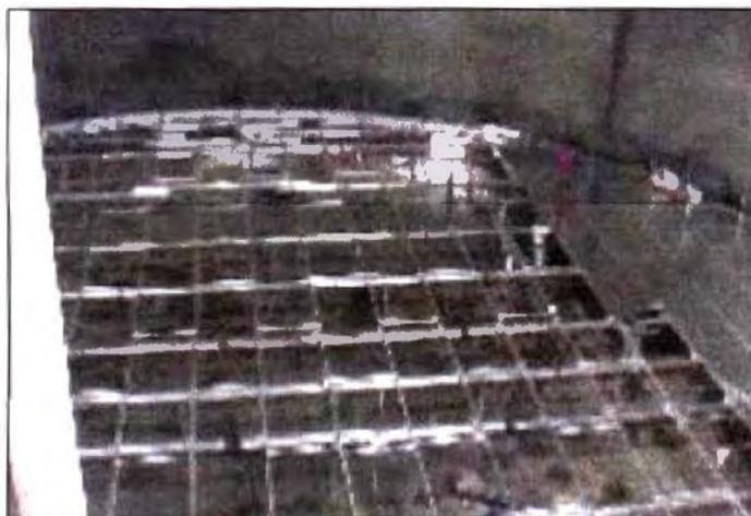
Figura 2.3 – Membrana interior para tanques de techo fijo
