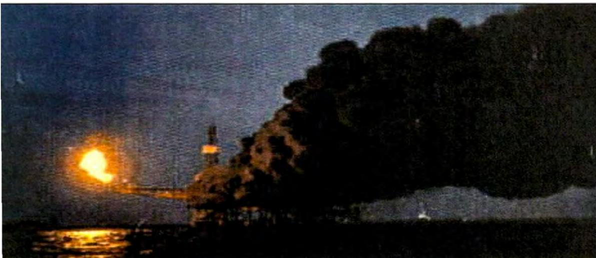
El accidente fue producido por la ignición de una fuga de gas a través de un agujero en una línea por el retiro para reparación de una válvula de alivio. El accidente se agravó por una cadena de decisiones relacionadas al manejo de la emergencia, no pudiéndose controlar los efectos de la primera explosión..
