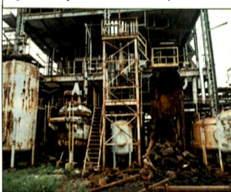
produjo cuando 1000 kg de agua ingresaron por error a un tanque de almacenamiento de MIC, ocasionando que se produzca vapor de MIC altamente inflamable. Este vapor no pudo ser neutralizado pues el scrubber de la línea de venteo estaba en mantenimiento y escapó al ambiente produciendo una nube tóxica que se propagó por la población adyacente.
