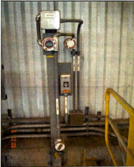
Figura 2,9(b): Fotografías de las alarmas sonora y visual de alto nivel de ácido cianhídrico.
