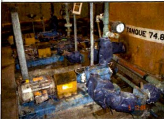
Figura 2,8(d): Fotografía de las bombas de sumidero para recuperación de derrames.
