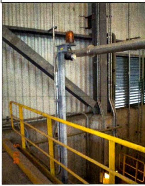
Figura 2,9(c): fotografía de las alarmas en la zona externa del edificio.
