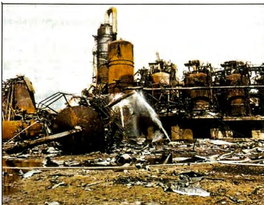
El problema fue que la tubería de by-pass se construyó de una tubería flexible la cual se le colocaron estructuras de soporte insuficientes por su carácter “provisional”, Esto ocasionó la ruptura de la tubería por la fatiga ocasionada por el movimiento provocado por la presión de los reactores.
