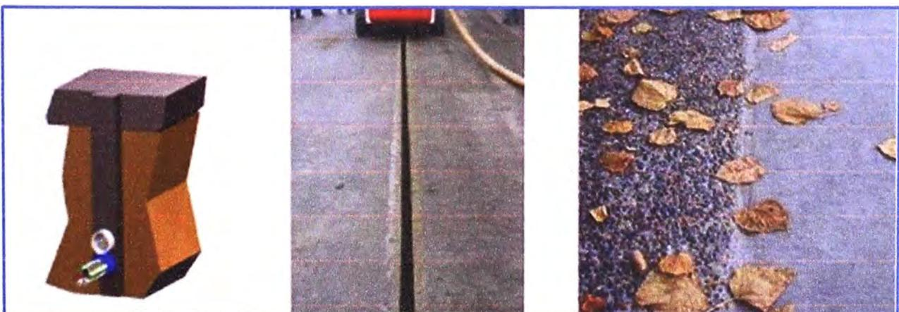
**Figura 3.9** a) Esquema de instalación de cable en microzanjas; b) Realización de una microzanja; c) Aspecto final tras el proceso de rellenado.
