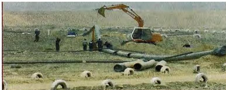
**Foto 20:** Termofusión de tuberías
