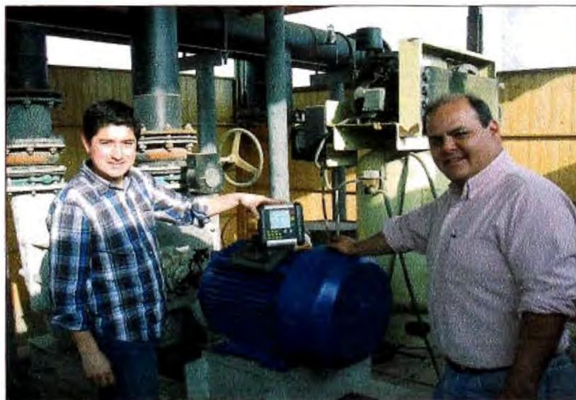
**Foto 33:** Revisión del alineamiento láser de motor soplador
