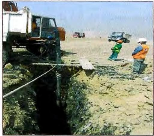
**Foto 13:** Colocado de tubería
