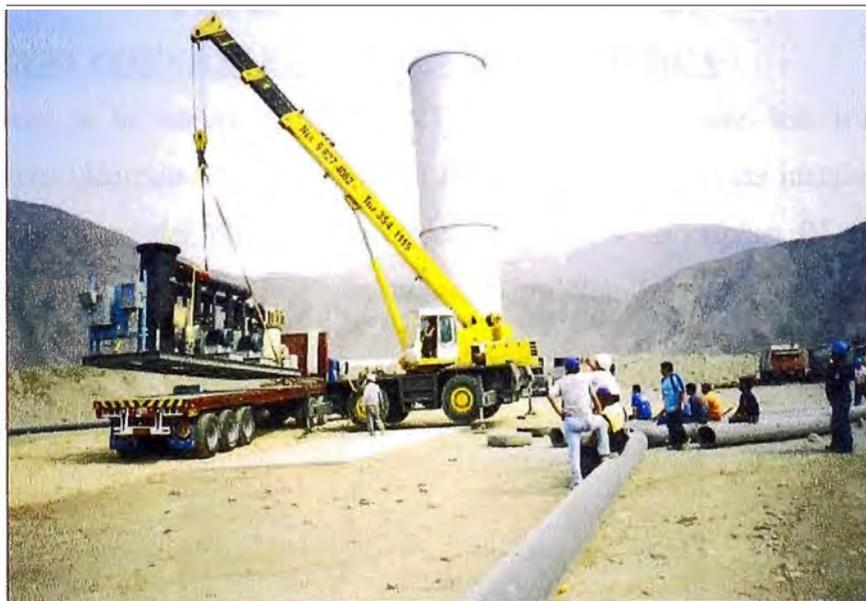
**Foto 27:** Montaje del Blower skid Assembly de la Cía. John Zink
