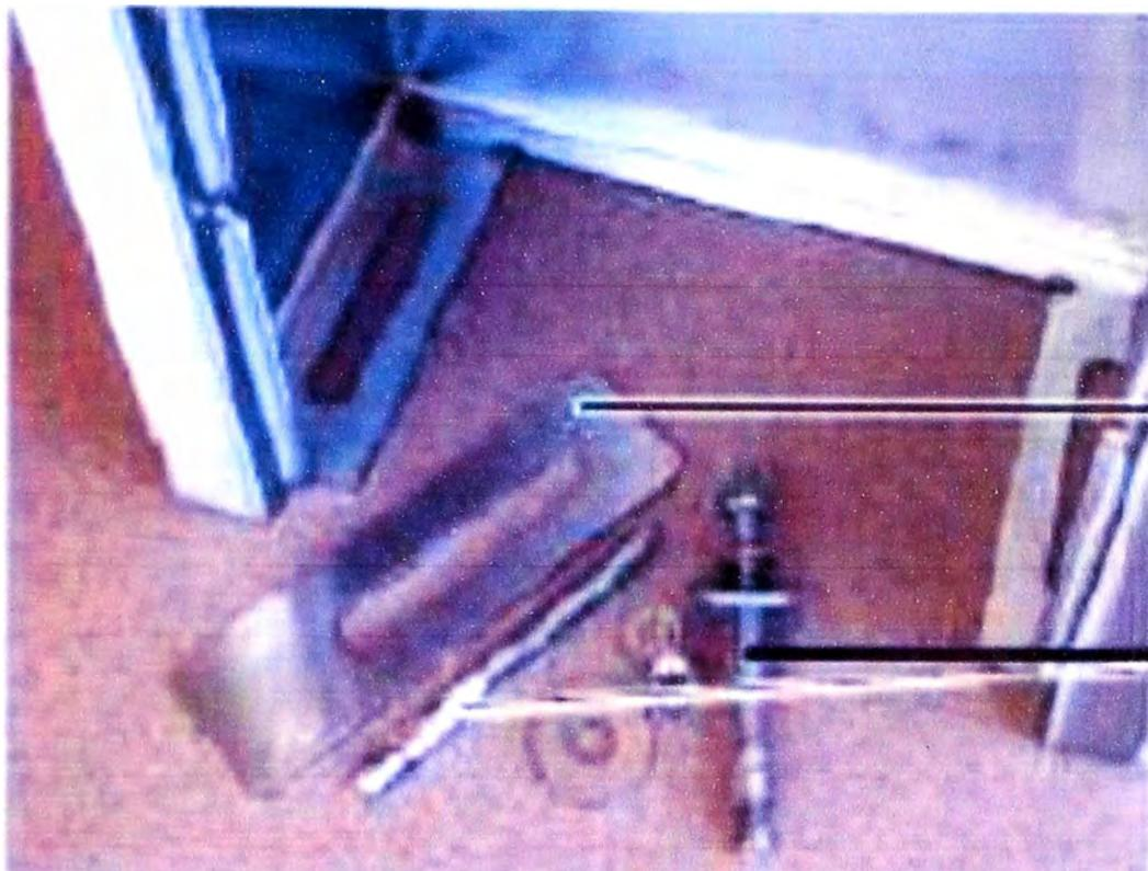
Figura 4.16 Placa de sujeción y perno de fijación
