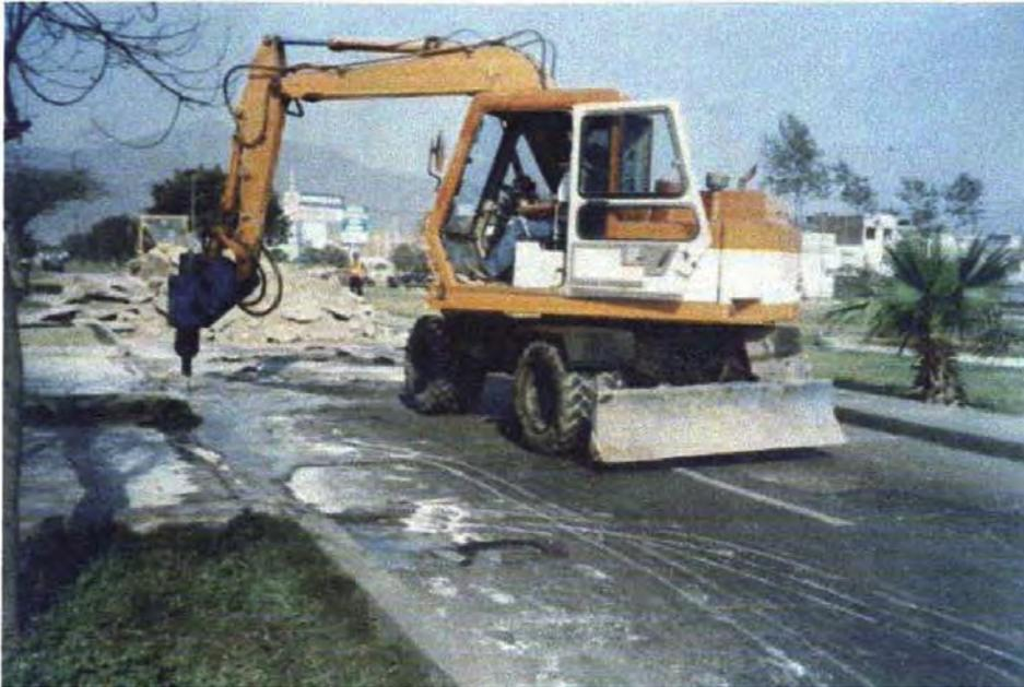
Demoliciones. Picado de pavimento de concreto. Maquinaria
