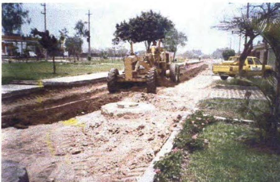
Movimiento de tierras. Excavación de sub rasante y equipo.
