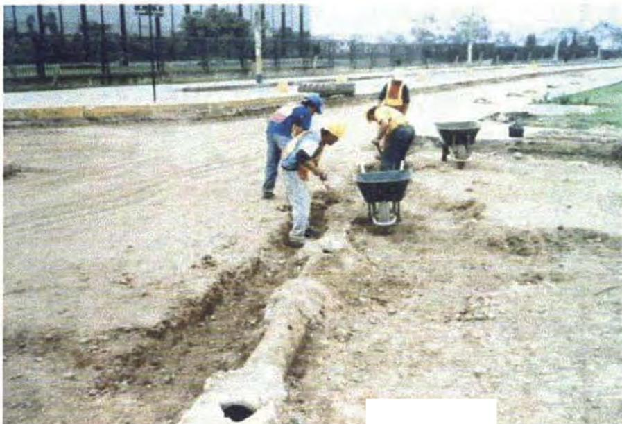
Obras varias. Rotura de tubería de agua.
