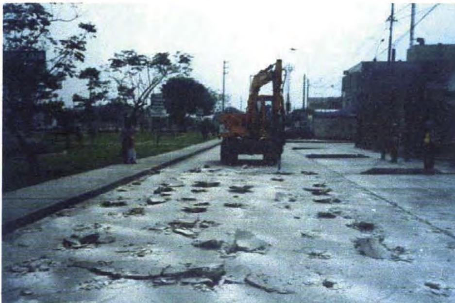
Demoliciones. Picado de pavimento de cemento
