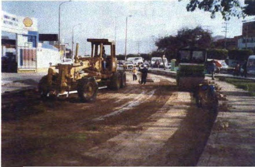
Pavimentación. Conformación de la sub rasante y compactación.
