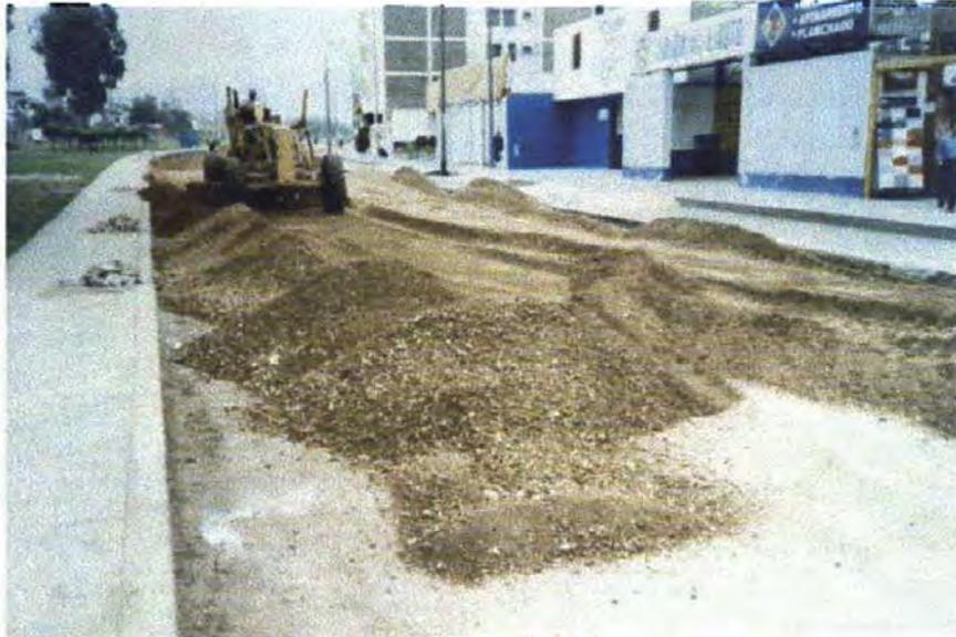
Pavimentación. Conformación de la sub rasante.
