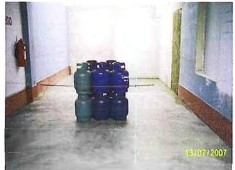
Observar la distancia del área de almacenamiento hacia las paredes (capacidad < 200 kg)
