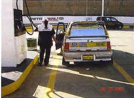
Observar altura de la isla (mínimo 0.2 m) y distancia entre el dispensador y el vehículo (mínimo 0.5 m)
