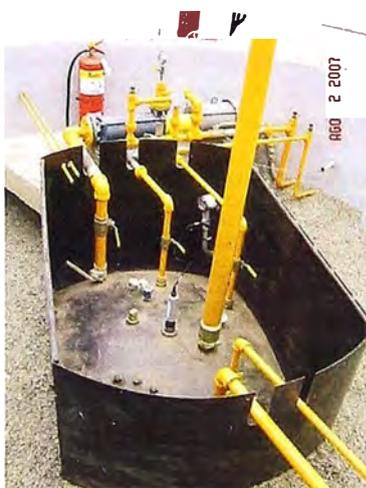
Vista del entubado de la válvula de seguridad de un tanque de GLP
