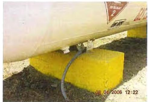
Tanque nivelado y anclado a bases de concreto
