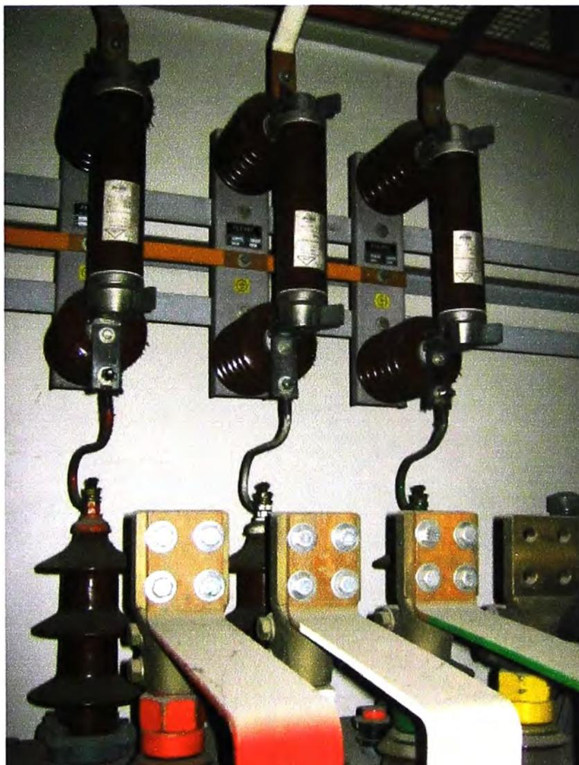
**Fig. 2.2** Fusibles, Protección básica de una subestación.
