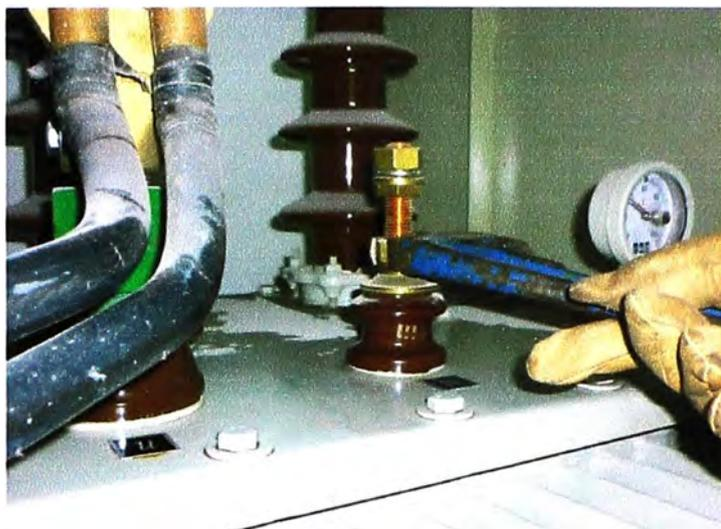
**Fig. 4.3** Verificación de Ajuste de Terminales
