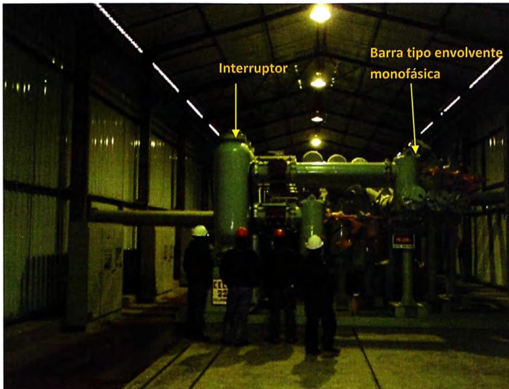
4. Vista de interruptor de potencia, disposición vertical.
