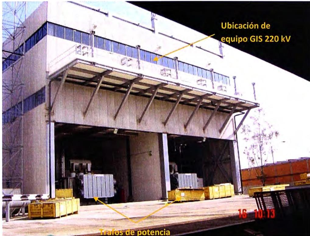
2. Se observa la conexión a los transformadores de potencia mediante tubo GIS, para el presente proyecto será mediante cable EPR 220 kV.
