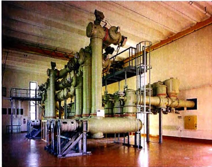
**Fig. 3.2:** Arreglo de una subestación GIS.
