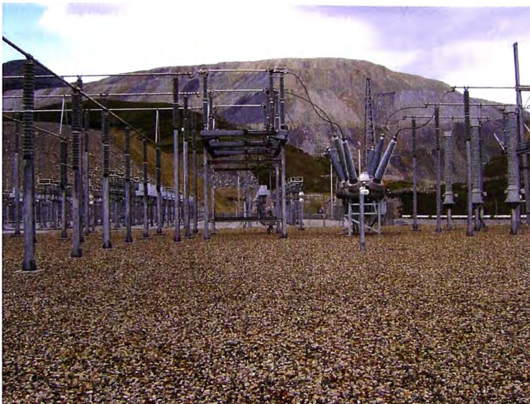
**Fig. 3.1:** Arreglo de equipos en una subestación AIS.
