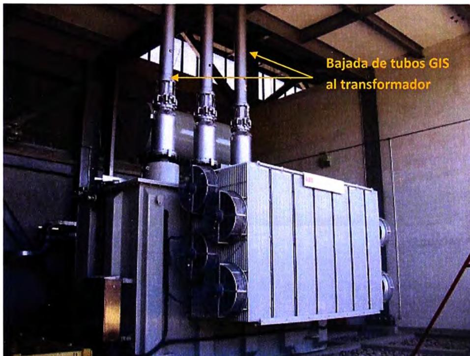
3. Detalle de bajada de tubo hacia los trafos de potencia, para el presente proyecto será cable EPR 220 kV.
