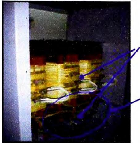
**Fig. 3.9** Ajuste de terminales y limpieza de transformador
