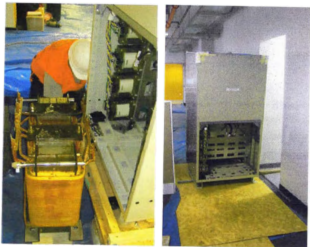
Figura 5.17: Montaje de Transformador de Aislamiento de 75kVA (UL).
