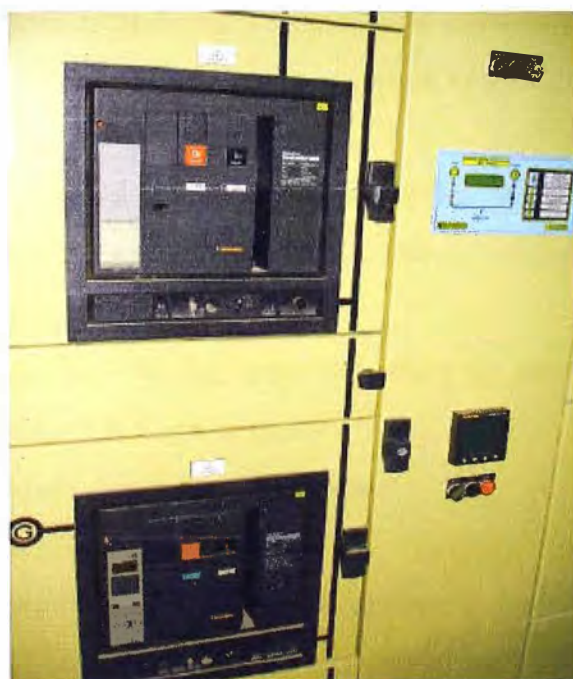
Figura 3.4: Módulo de conmutación Red de Suministro – Grupo Electrónico
