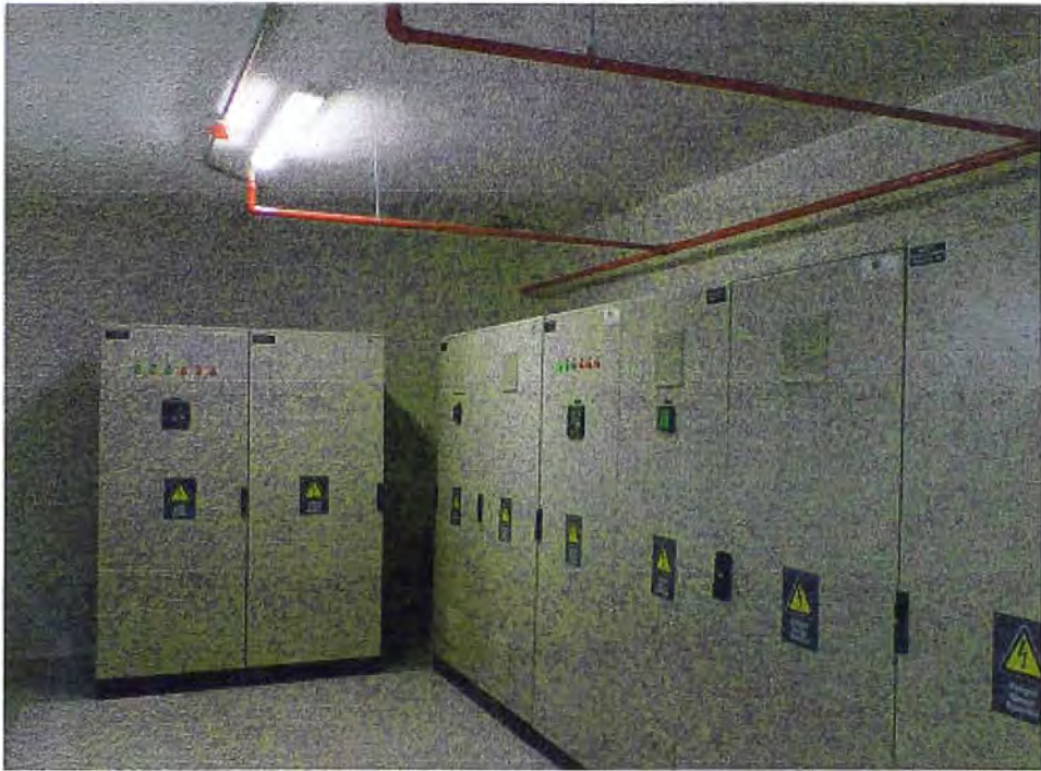
Figura 5.15: Montaje de Tableros Eléctricos en “Cuarto de Tableros”.
