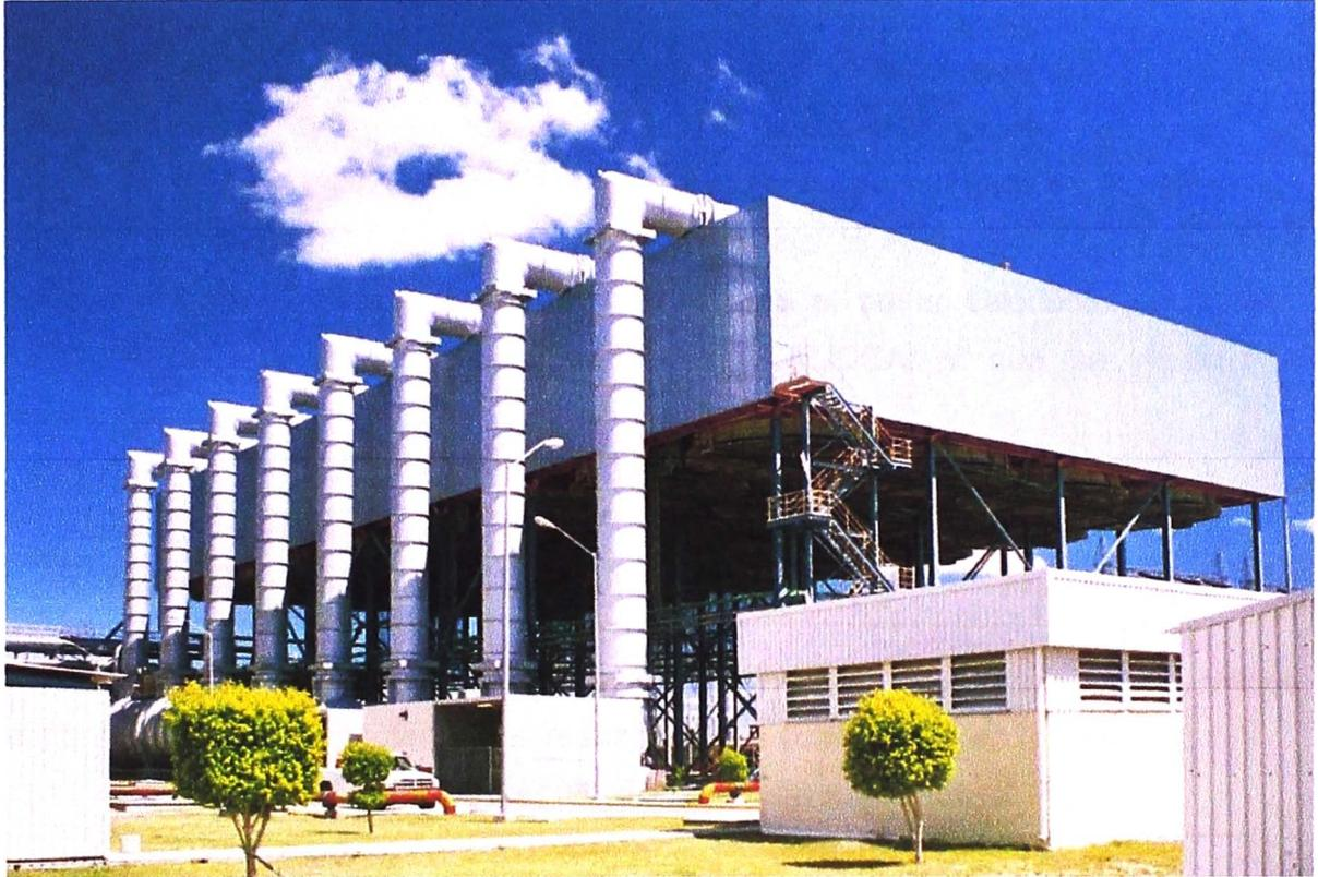
**Fig. 2. 21 Vista de un Aerocondensador**
