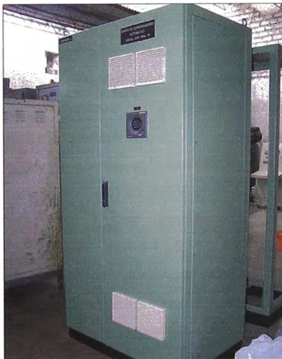
**Fig. 4.4** Banco de condensadores de dos cuerpos (vista exterior)
