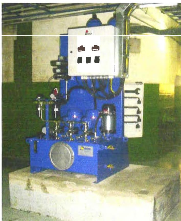
**Fig. 4.4 Unidad de Potencia Hidráulica del RV**
